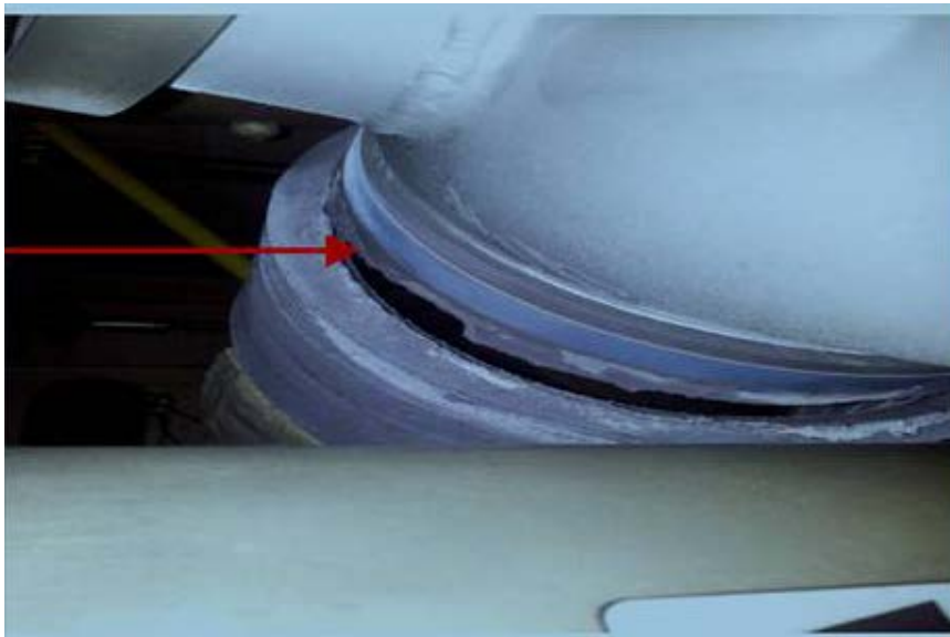
圖 2-6：事故機空調系統連接管路的套筒破裂（紅色箭頭處）
