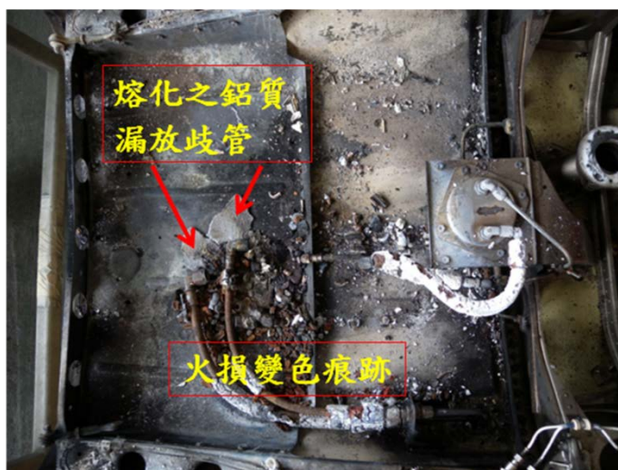
圖 2-2：GE515 一號發動機進氣口後段底部整流罩結構火損圖
