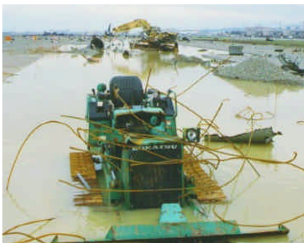
圖 1.4-3 推土機（在 11 號坑洞內）
