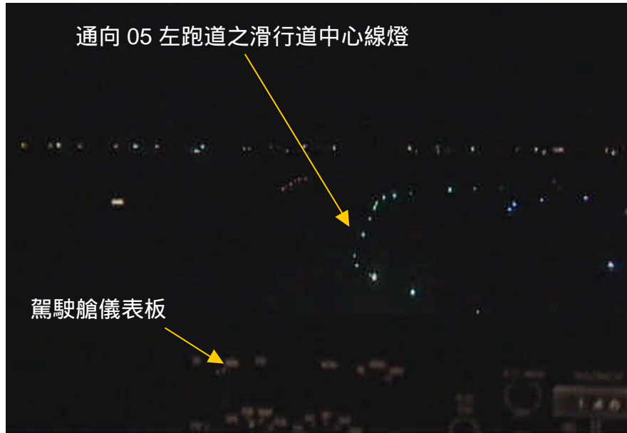
圖 1.16-1 通向 05 左跑道之滑行道中心線燈（由波音 747-400 正駕駛位置之視野）
