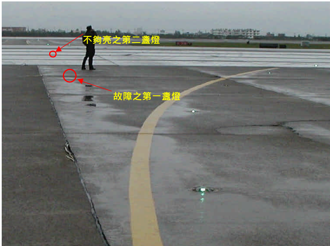
圖 1.10-10 05 右跑道頭處之 N1 滑行道中心線燈情況 (攝於八十九年十一月四日)
