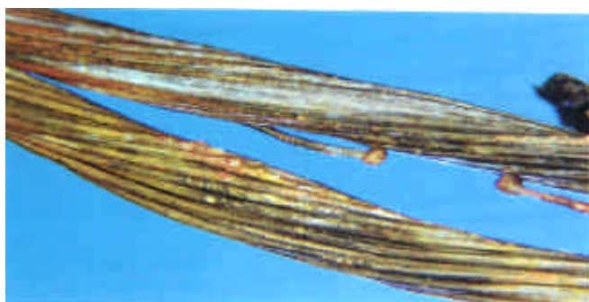
圖 1.16-7 RE240-1 靠近脫落絕緣層之局部熔融現象
