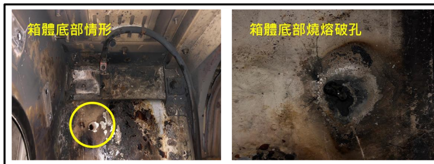
圖 1.14-2 民國 107 年電感電容濾波器燒損相片-2
