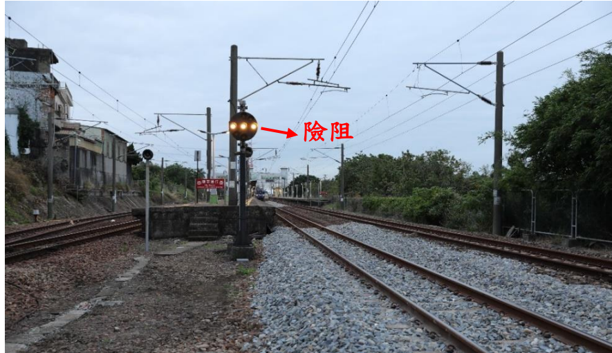
圖 1.1-4 通霄站第三股道北端出發號誌預告機（非事故當時拍攝）
