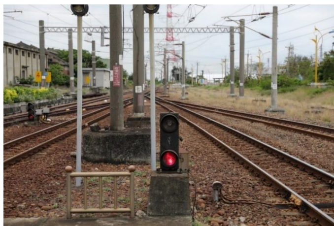
圖 1.9-6 通霄站第三股道出發號誌機（非事故當時拍攝）
