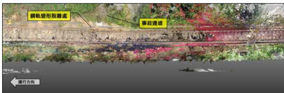
圖 1.11-14 鋼軌變形脫離狀況
