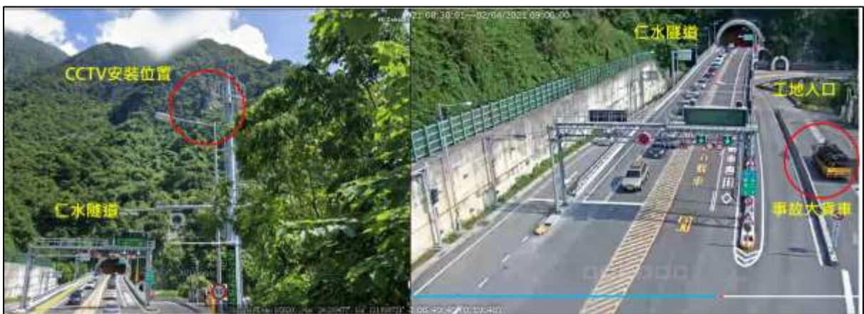
圖 1.10-23 台 9 線 CCTV R-158.226 安裝位置及畫面相關資訊
