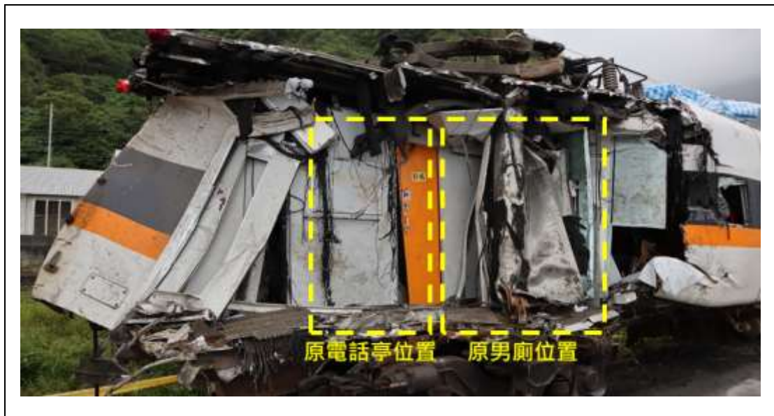
圖 1.13-12 第 6 車前端受損情形
