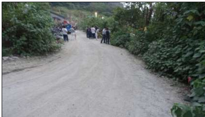
圖 2.1-1 事故發生時施工便道鋪面狀況
