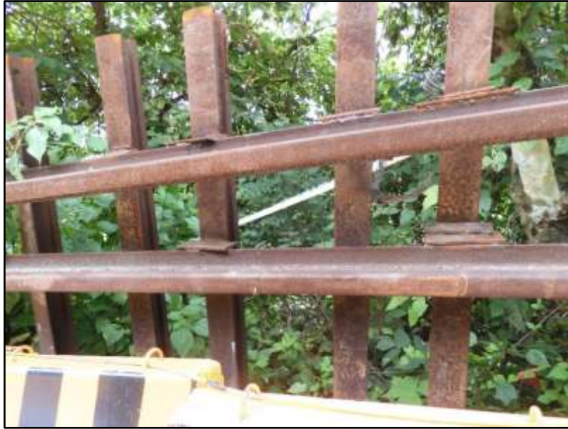
圖 2.4-1 事故後裝設於施工便道旁與邊坡上方之鋼軌樁及鈕澤西護欄
