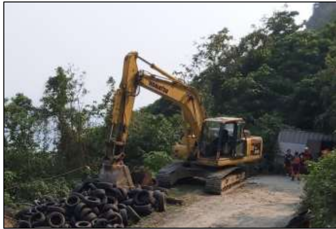
圖 1.8-3 事故挖掘機外觀照片
