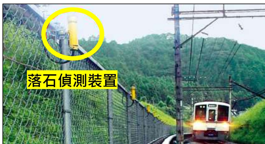
圖 1.7-11 西武鐵道落石偵測告警裝置 16
