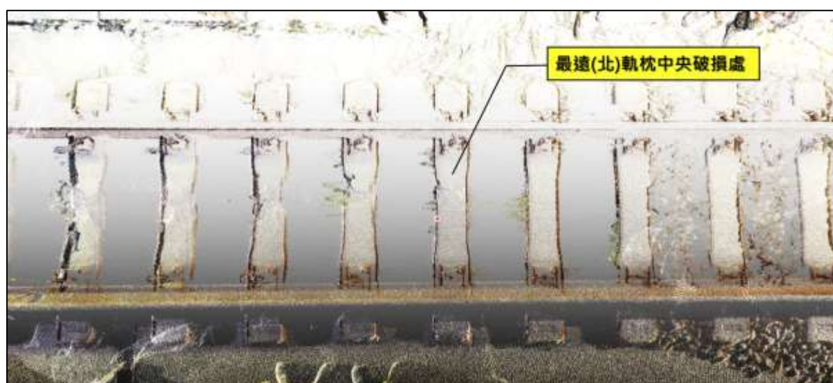
圖 1.11-13 受破壞最遠處軌枕狀況
