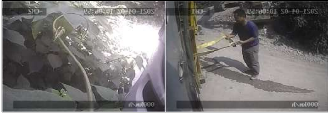
圖 1.10-29 工地主任將吊帶綁上大貨車立柱
