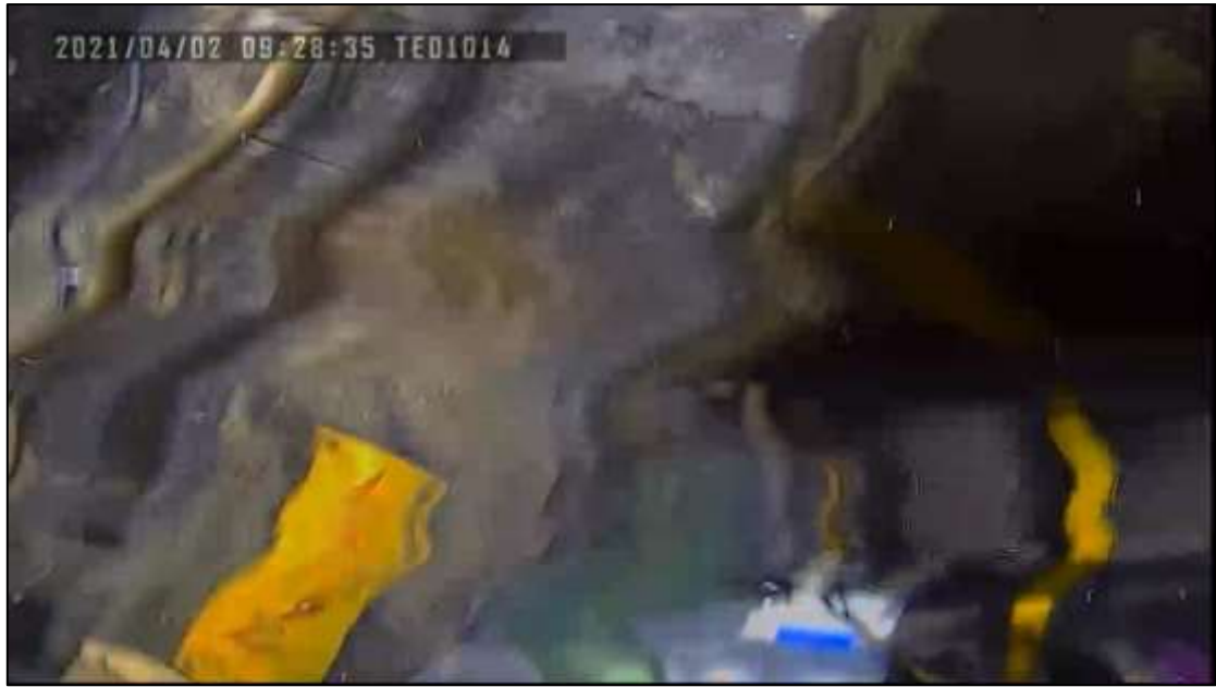
圖 1.10-39 列車撞及清水隧道北口東側
