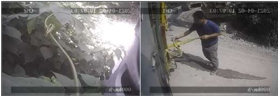
圖 1.10-30 工地主任將吊帶綁上大貨車立柱
