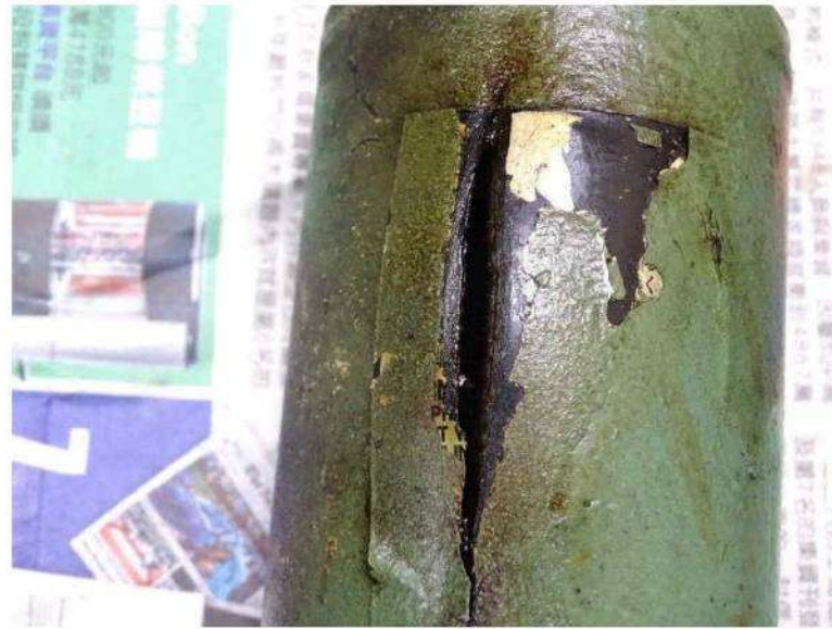
照片六：3 號發電機回油端減震器斷面呈現快速破壞形貌
