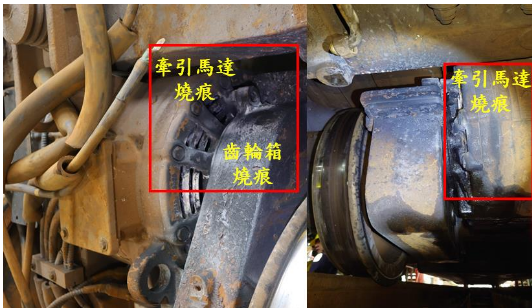
圖 1.2-2 第 2 轉向架第 1 車軸設備損害情形-1
