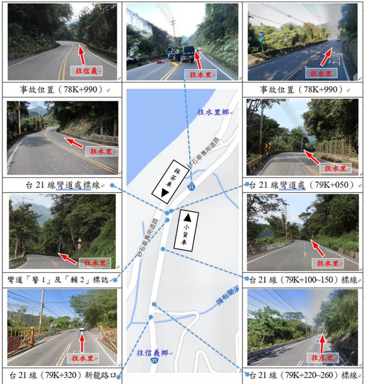
圖 1.8-2 事故地點附近道路工程現況
