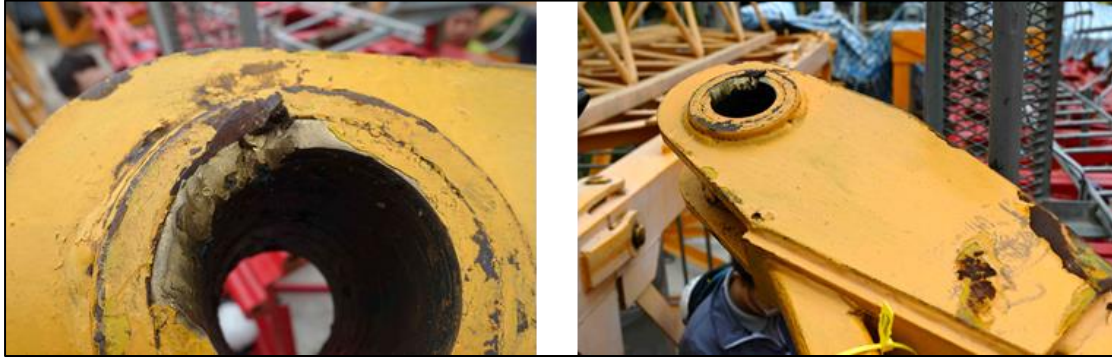
圖 1.3-4 塔式起重機桁架根部損害情形（非事故當日拍攝）
