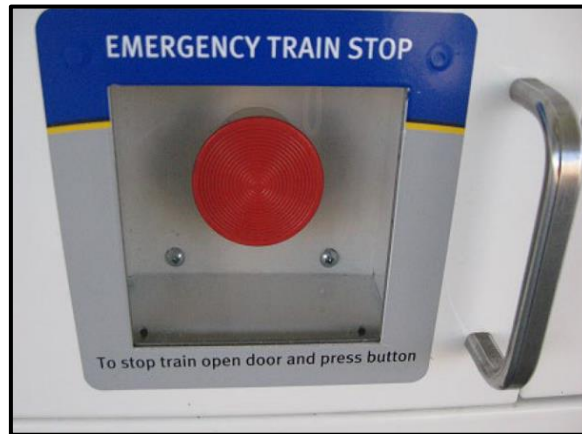
圖 1.13-1 加拿大溫哥華 SkyTrain 月台設置之緊急停車按鈕
