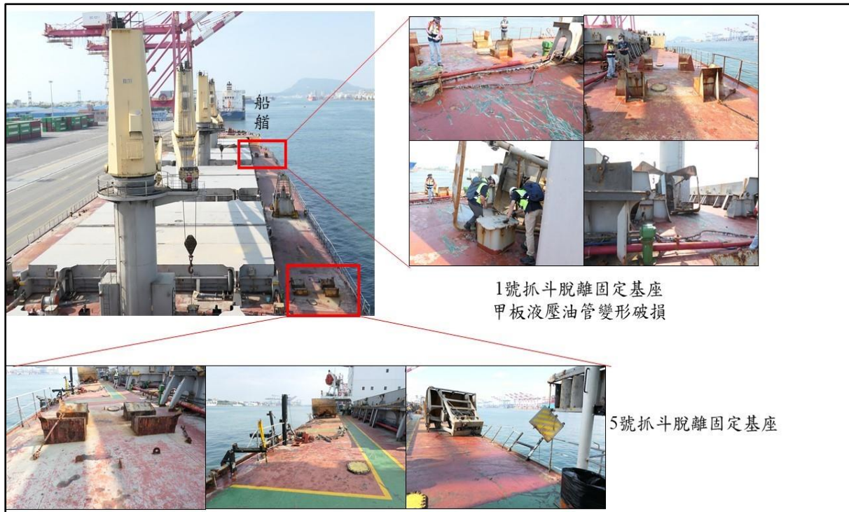
圖 1.3-1 主甲板右舷抓斗及油壓管受損照片
