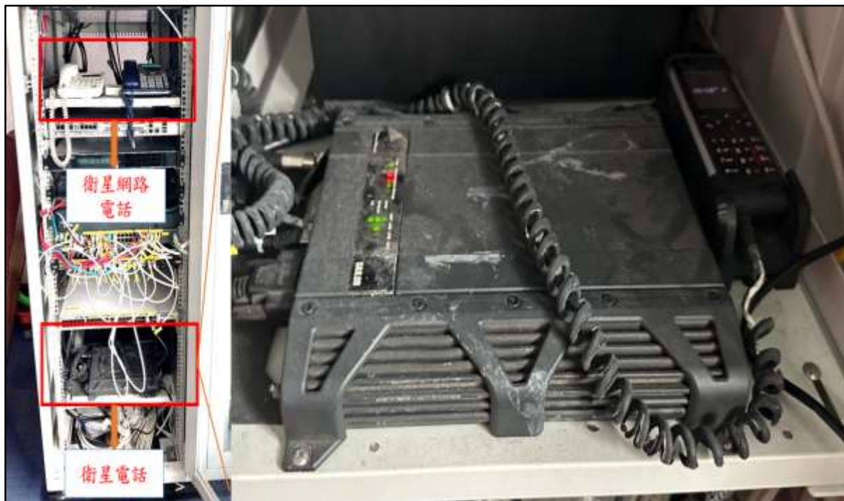
圖 4 新海研衛星電話及衛星網路電話布置
