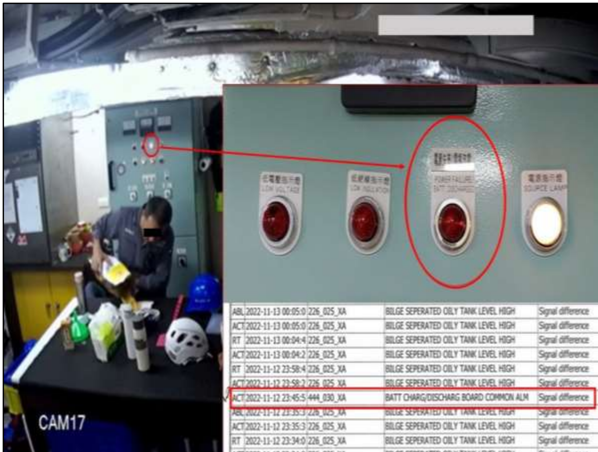
圖 13 充電盤電源失效燈亮及機艙警報
