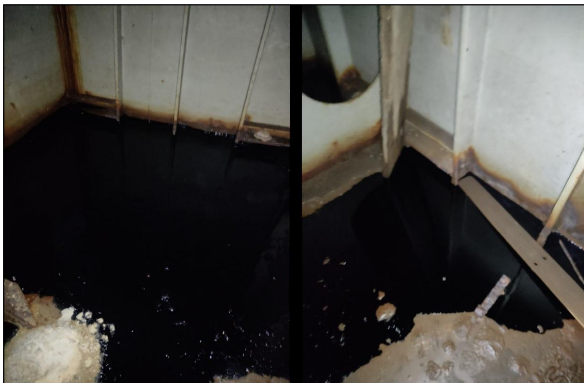
圖 1.1-2 天使輪第4貨艙前段漏油至第4貨艙中間走道圖
