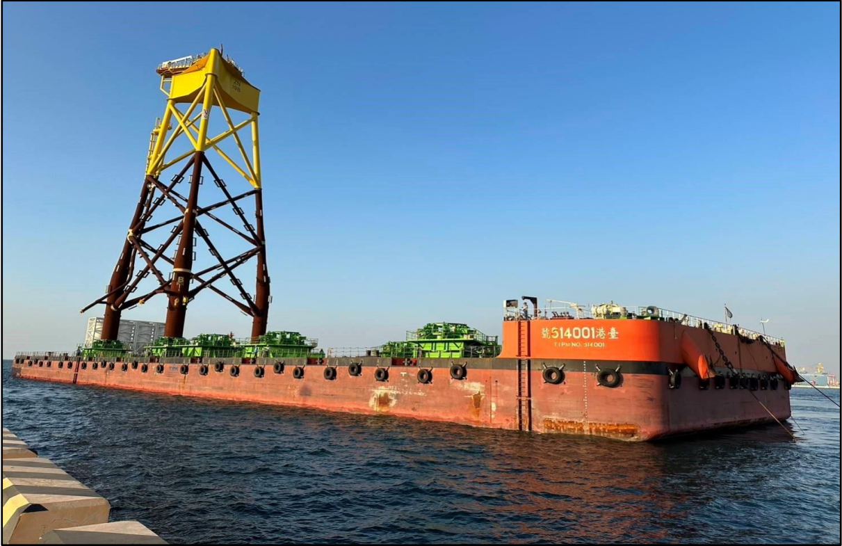
圖 1.1-2 運輸駁船靠泊高雄港時之外觀圖（事故後）
