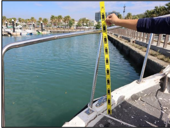
圖 1.14-4 「進」船船艙護欄高度約 84 公分
