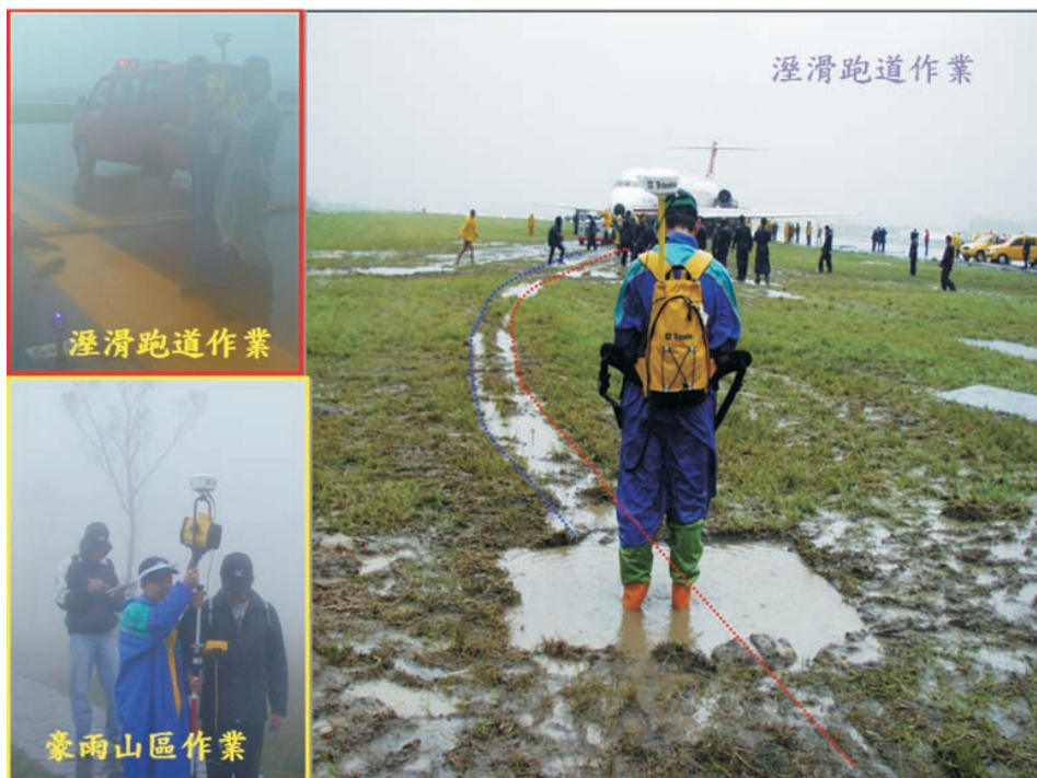
現場量測作業情形
