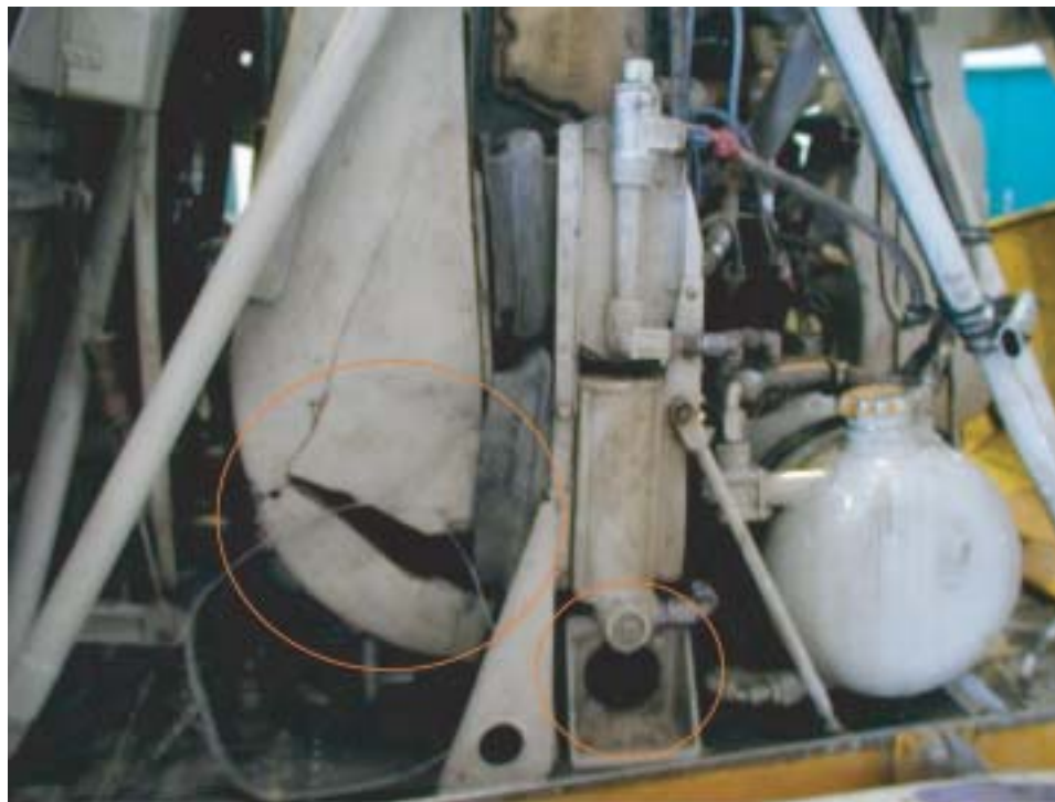
圖 1.12.4.2-10 滑油冷卻器風管與左發動機避震接腳
