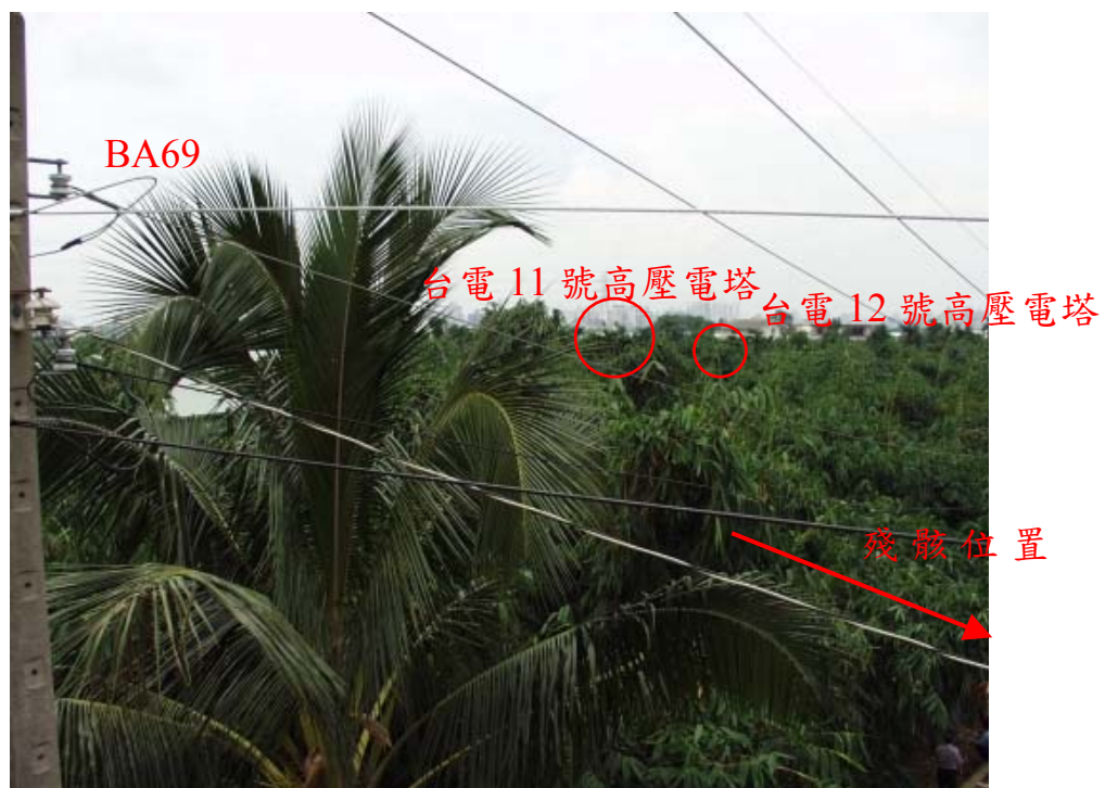
圖 1.12.2-7 自 BA69 電線桿旁台電 11、12 號高壓電塔
