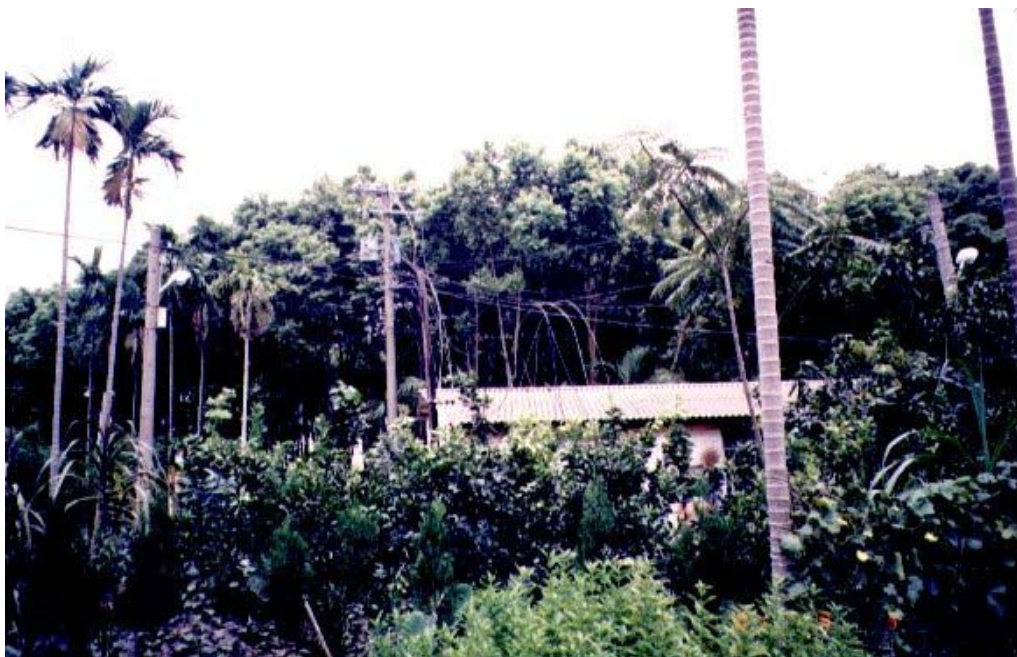
圖 1.4 台電高低壓輸電電纜遭撞斷情形
