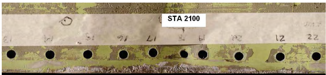
圖 1.16-6 修理補片內表面邊緣之淡色沉澱物
