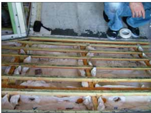
圖 1.12-2 (A) 後貨艙檢查照片_地板與隔熱毯拆除
