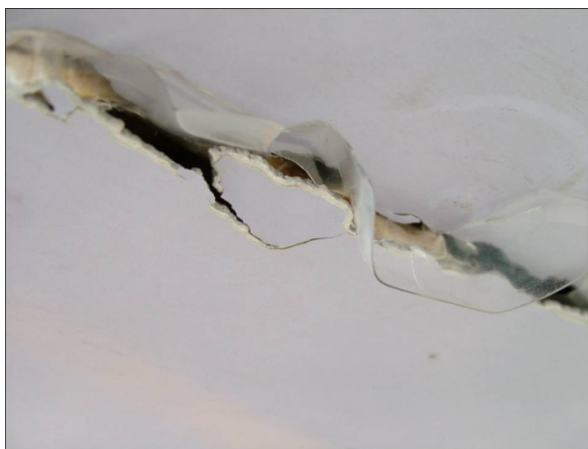
圖 1.12-1 (D) 機腹裂縫細部照片
