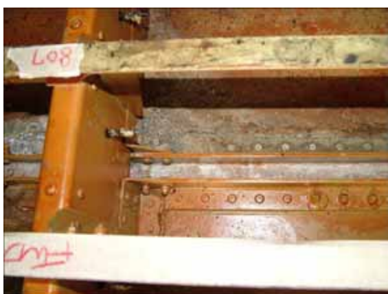
圖 1.12-2 (E) 站位 807 隔框前側蒙皮腐蝕細部照片
