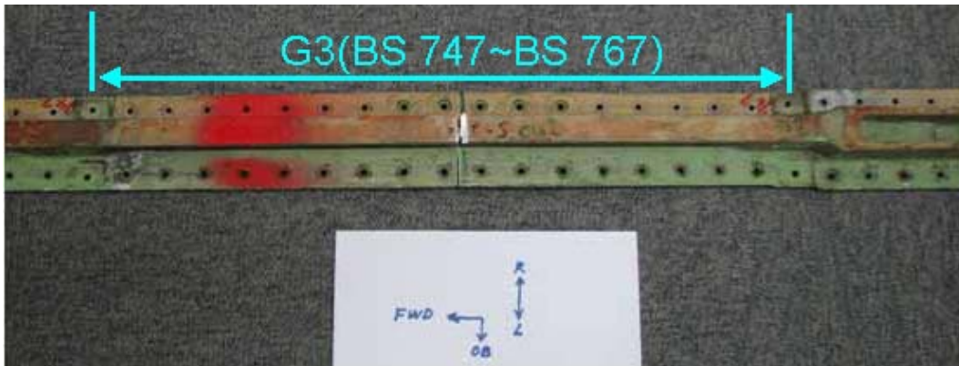
圖 1.12-27 G3 區縱桁腐蝕情形
