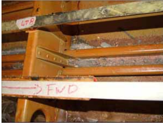
圖 1.12-2 (L) 站位 847 隔框前側照片
