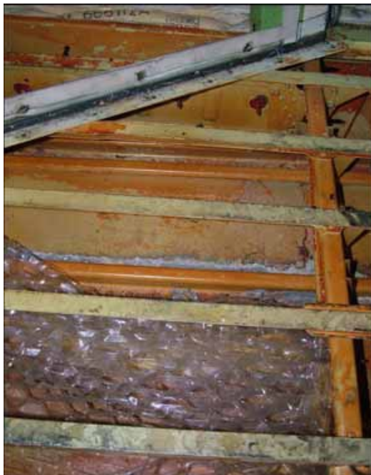
圖 1.12-2 (N) 站位 869.7 裂縫後端所在位置之貨艙內照片
