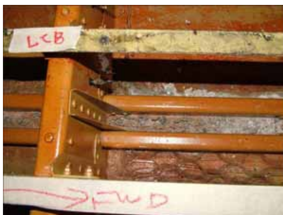
圖 1.12-2 (I) 站位 827 隔框前側照片
