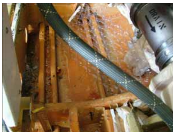
圖 1.12-2 (Q) 廢水櫃出口與縱向連接片相關位置照片
