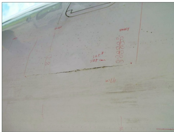
圖 1.12-1 (A) 機腹裂縫外觀照片
