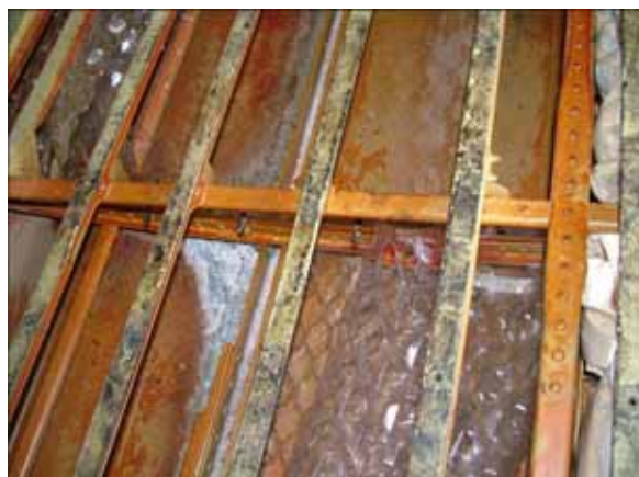
圖 1.12-2 (F) 站位 807 隔框後側照片
