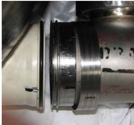
圖 1.18-2 廢水櫃出口管接頭間距
