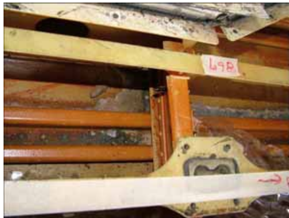
圖 1.12-2 (P) 站位 867 隔框後側照片
