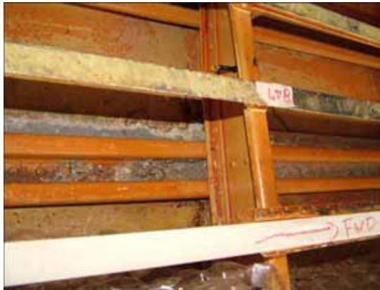
圖 1.12-2 (M) 站位 847 隔框後側照片
