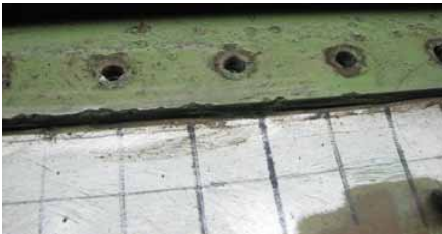
圖 1.12-28 G3 區腐蝕凹陷情形
