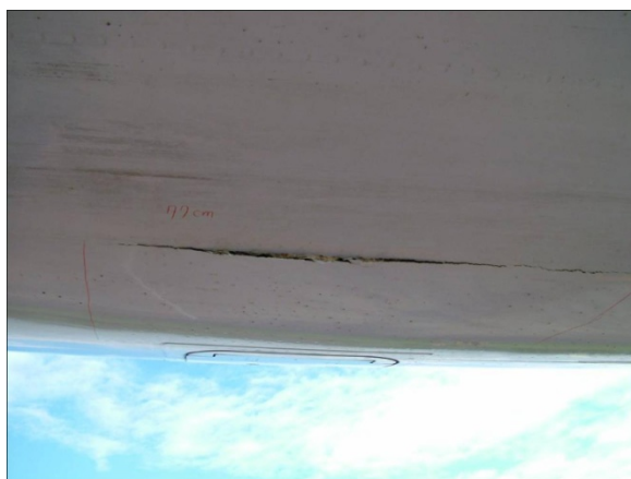
圖 1.12-1 (B) 機腹裂縫位置照片
