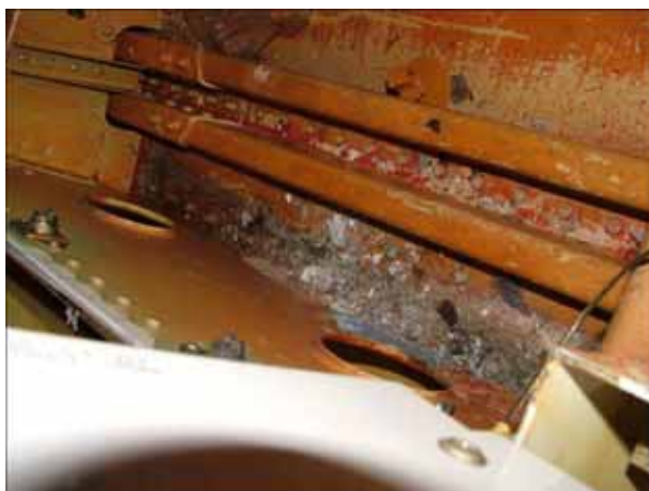
圖 1.12-2 (R) 縱向連接片腐蝕照片
