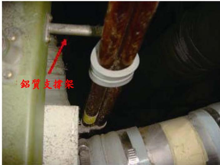
圖 1.6-1 輔助發電機電源線固定
