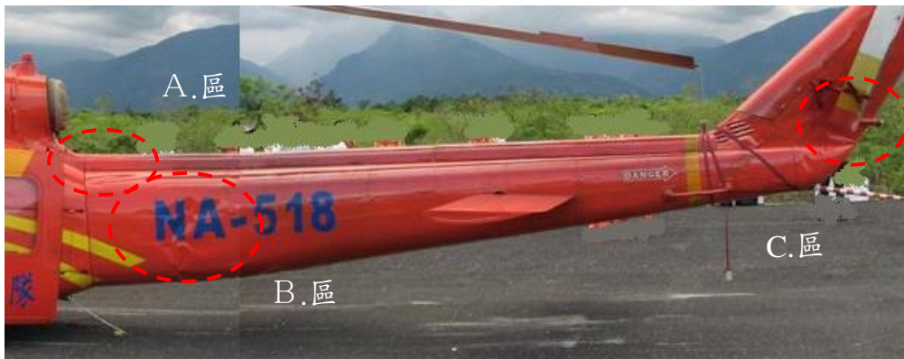
圖 1.12-5 尾桁左側蒙皮損傷
