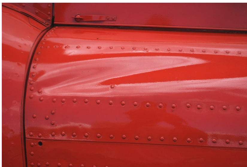
圖 1.12-6 尾桁左側前段 A 區蒙皮之皺褶變形
