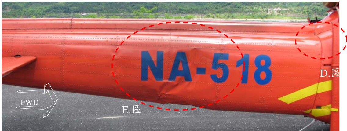
圖 1.12-10 尾桁右側蒙皮損傷分佈圖 - D 區與 E 區
