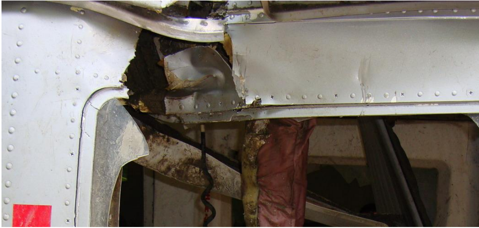
圖 1.12-10 (a) 左側機身客艙門框上部結構
