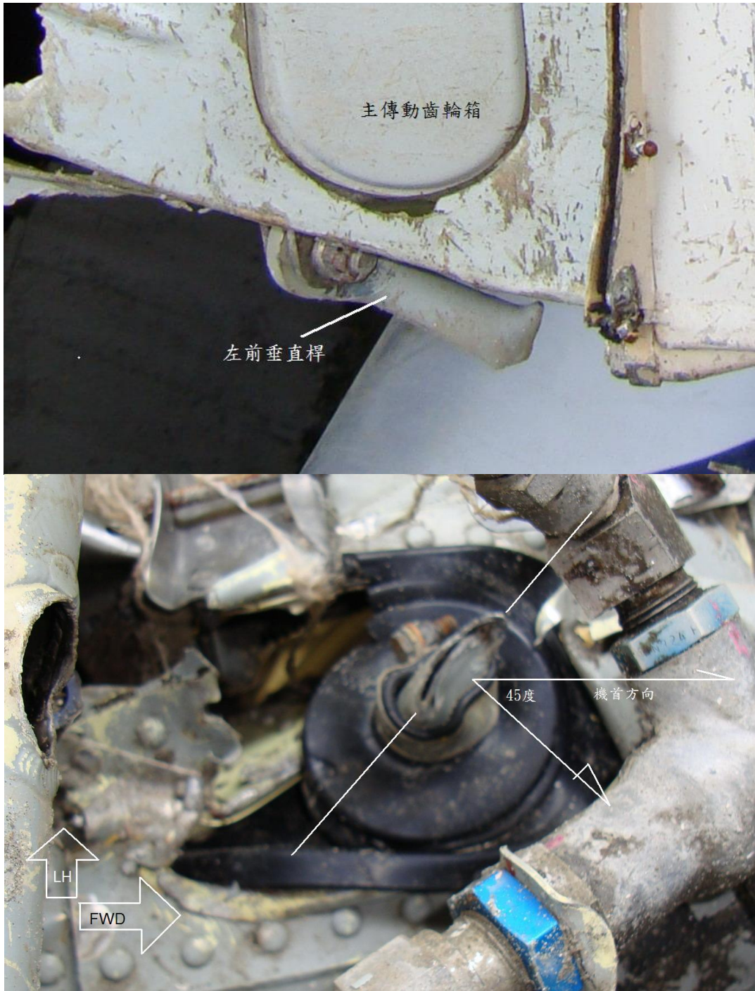
圖 1.12-4 (a) 主傳動箱左側前方垂直支柱結構斷裂
