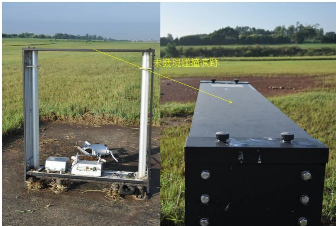
圖 1.12-18 24 跑道 5 千呎牌損害情形
