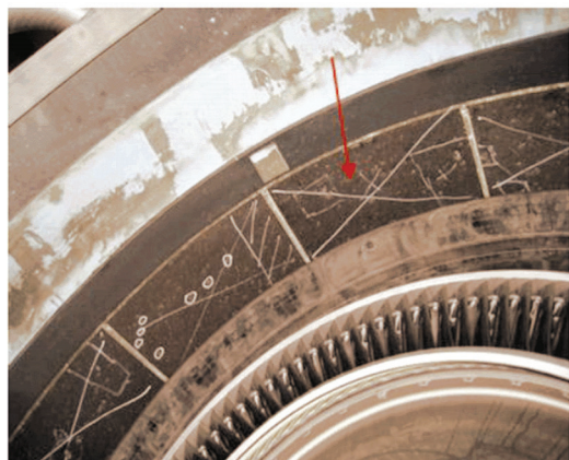
圖 1.12-18 隔音板損害情形 (4)
