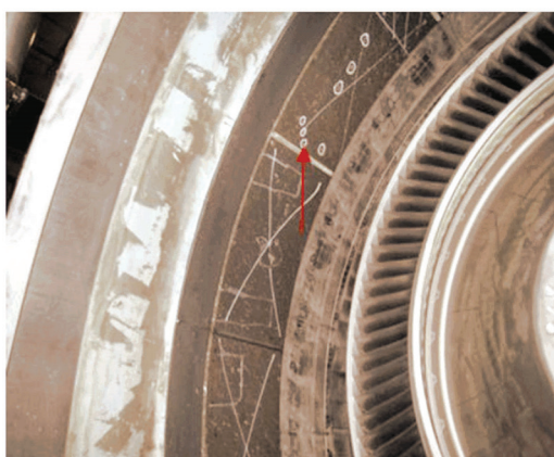
圖 1.12-17 隔音板損害情形 (3)
