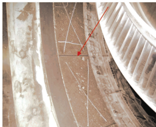
圖 1.12-20 隔音板損害情形 (6)
