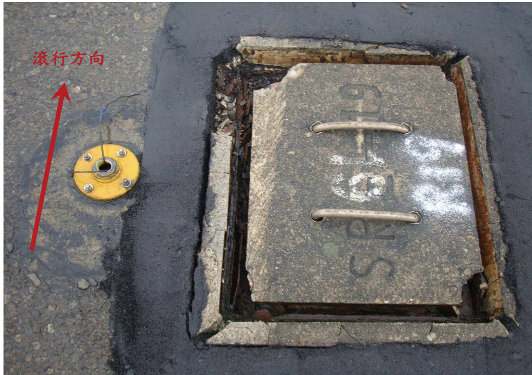
圖 1.12-1 損壞之跑道邊燈 (編號 R19)
