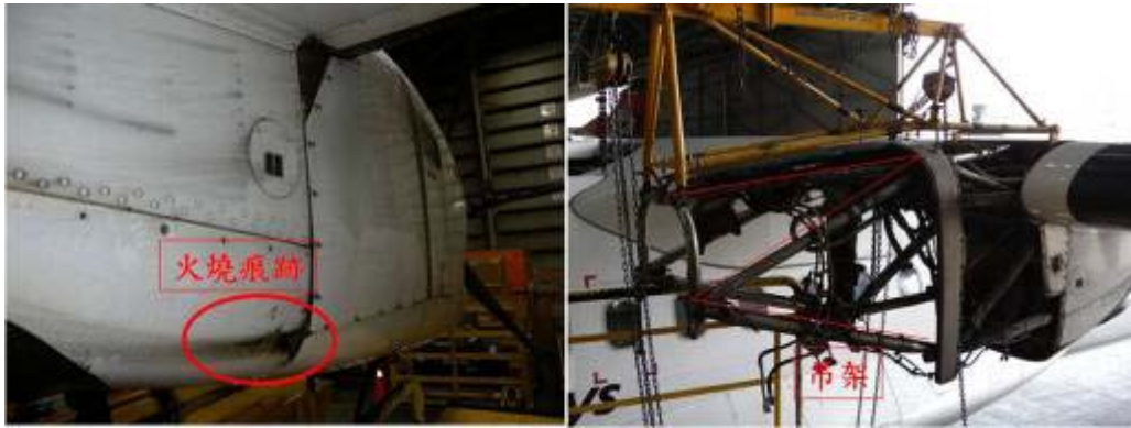
圖 1.14-1 機翼下箱型結構整流罩火燒痕跡及吊架遭受熱損
