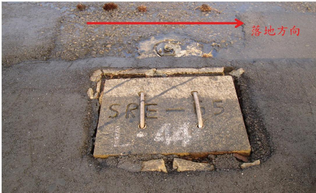
圖 1.12-3 損壞之跑道邊燈 (編號 L44)
