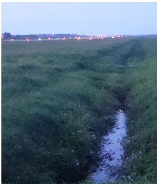
圖 1.10-11 跑道地帶整平區內未加蓋排水溝渠圖
