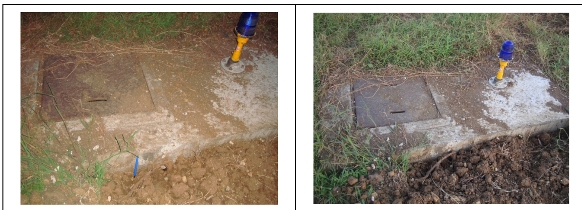
圖 1.10-10 編號 A 孔座水泥結構與滑行道邊燈圖
