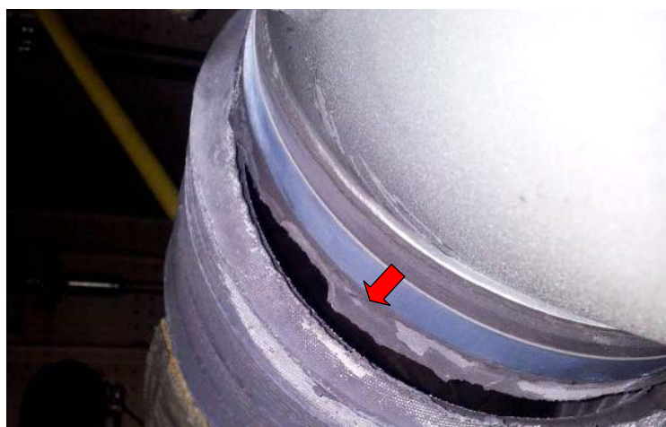
圖 1.6-4 一號空調機冷凝器與混合器間連接管路破損
