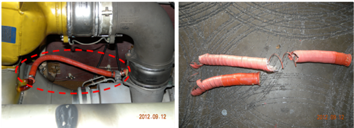
圖 1.16-2 一號空調機連接到冷凝器的熱空氣管
