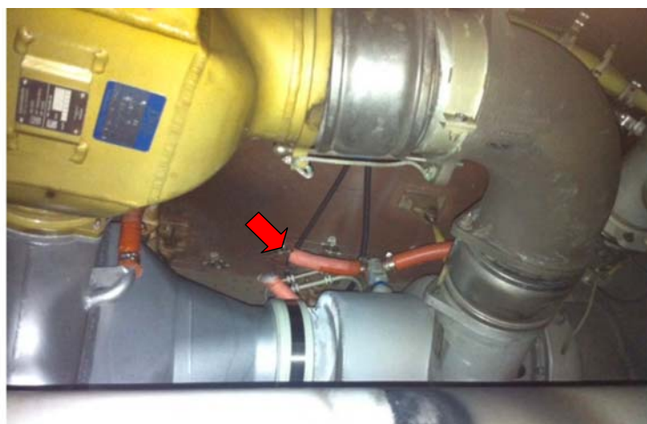
圖 1.6-5 一號空調機連接到冷凝器的熱空氣管斷裂
