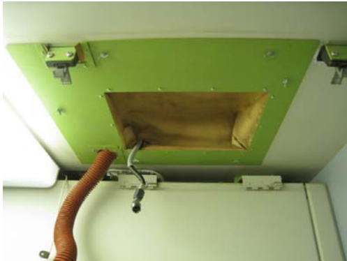
圖 1.12-1 3L 廁所天花板破損
