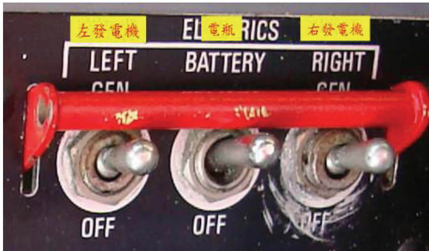
圖 1.12-25 左、右發電機及電瓶開關位置
