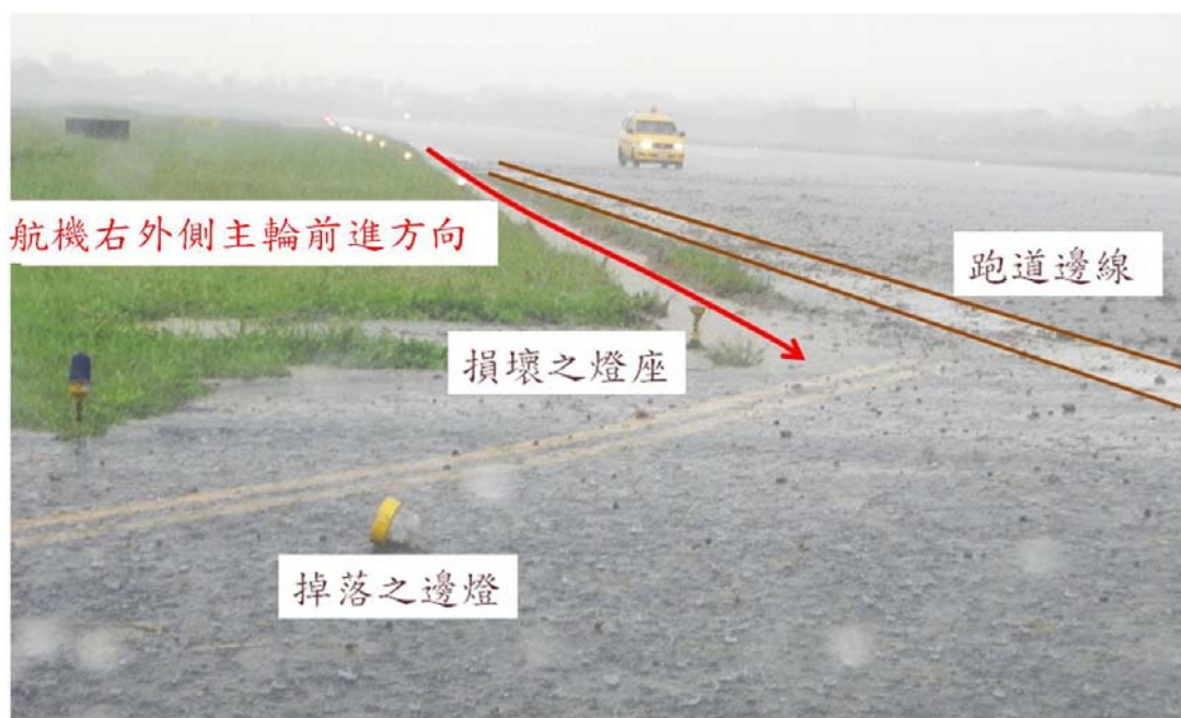
圖 1.12-2 損壞之編號 RE-1-124 跑道邊燈
