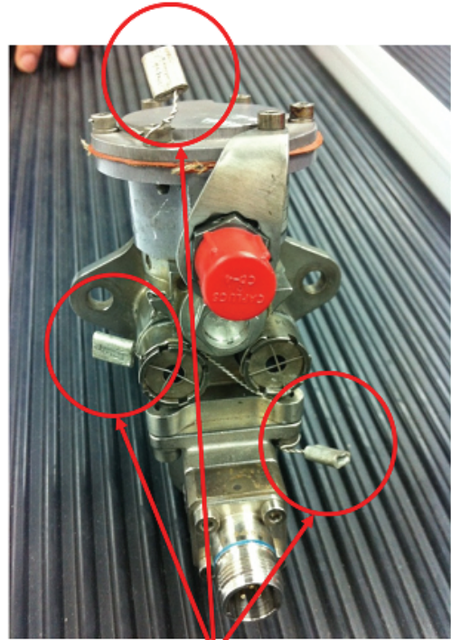
Lock wires and tags
