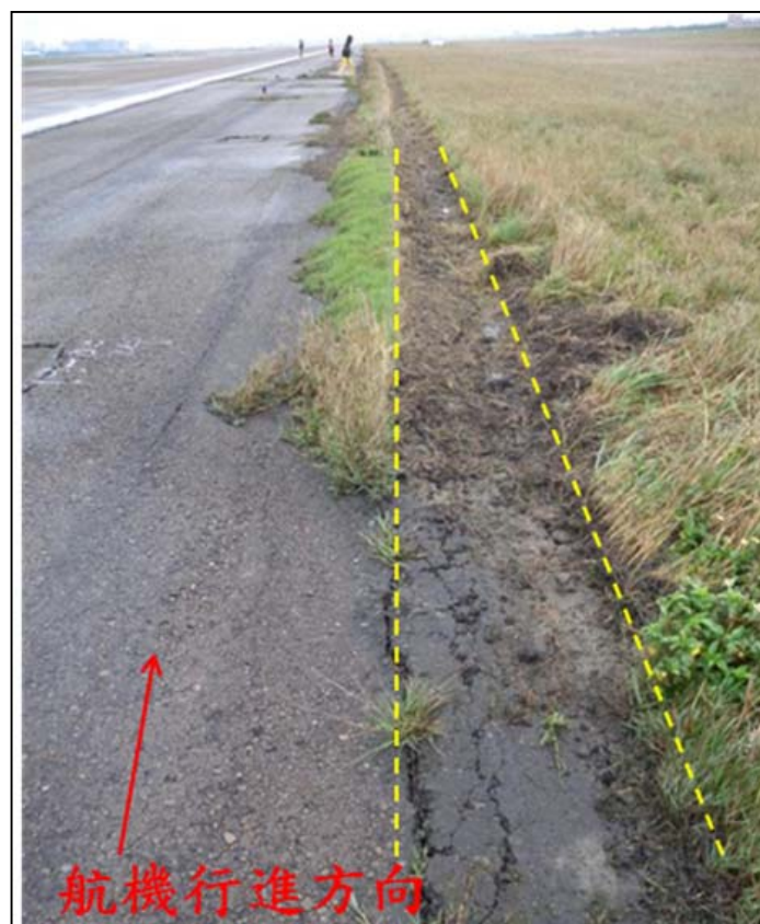
圖 1.12-3 右側主輪偏出跑道鋪面之胎痕
