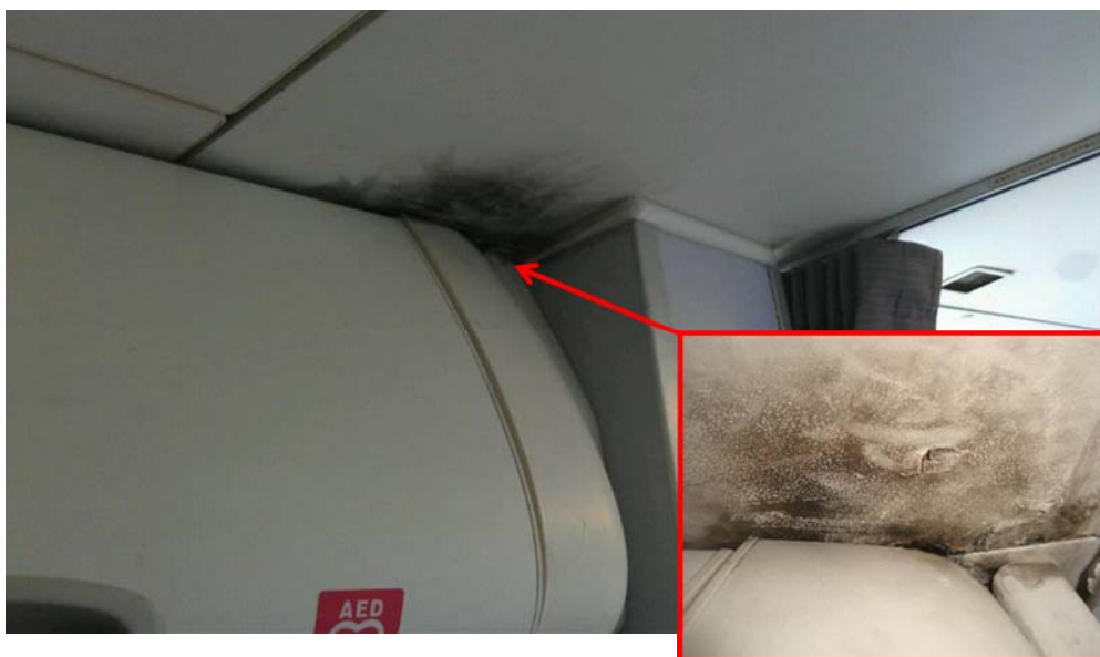
圖 1.14-1 客艙左側天花板燒焦積碳破洞情形
