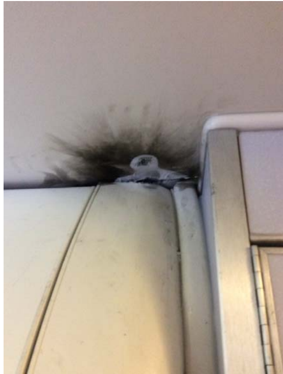
圖 1.1-1 天花板受損情形
