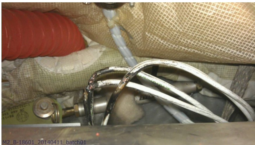
圖 1.1-2 電線損毀情形
