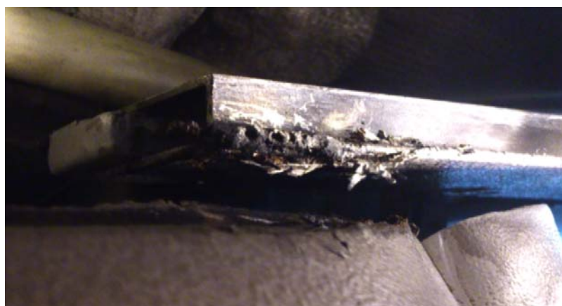
圖 1.14-2 左側天花板金屬固定樑熱熔變色情形
