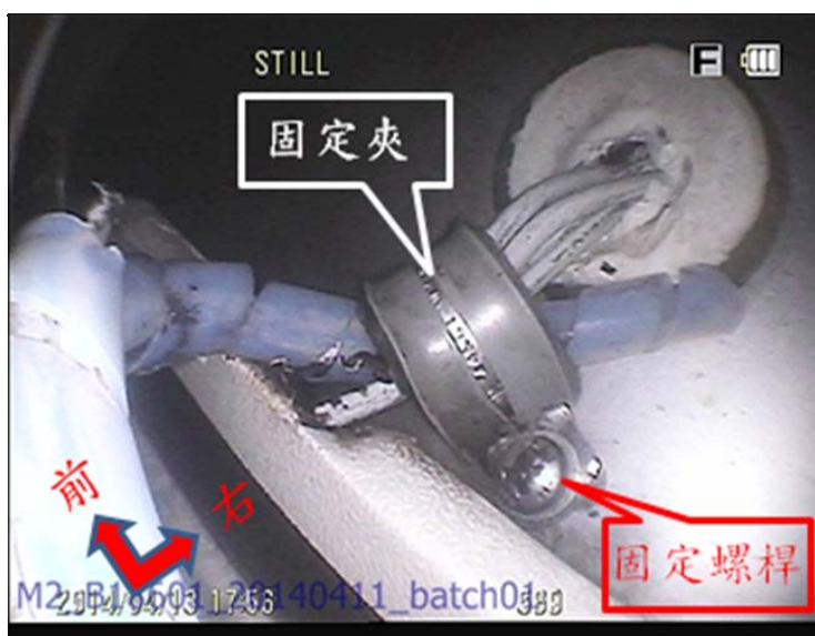
圖 1.6-4 FG2 電線與天花板邊緣發生擠壓情形
