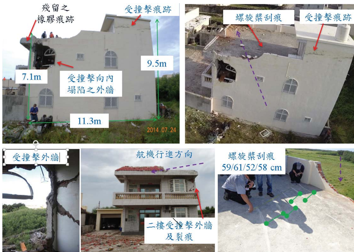
圖 1.12-9 第一棟遭受撞擊民宅之相關撞擊痕跡與破壞情形
