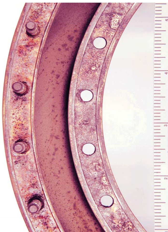
圖 1.16-21 壓縮器出口擴散器（近視圖）腐蝕情形
