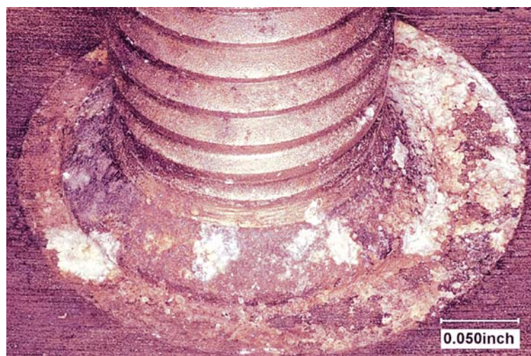
圖 1.16-18 壓縮器出口擴散器締緊螺絲腐蝕情形
