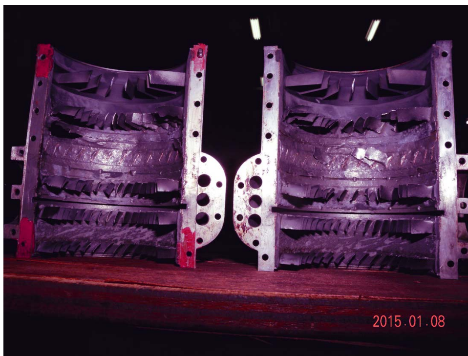
圖 1.16-12 定子導片損壞情形
