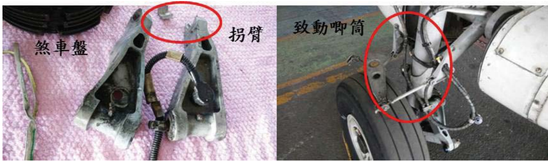
圖 1.12-5 右煞車盤拐臂及起落架致動唧筒損傷 左、右螺旋槳槳葉捲曲變形及刮裂如圖 1.12-6 所示。
