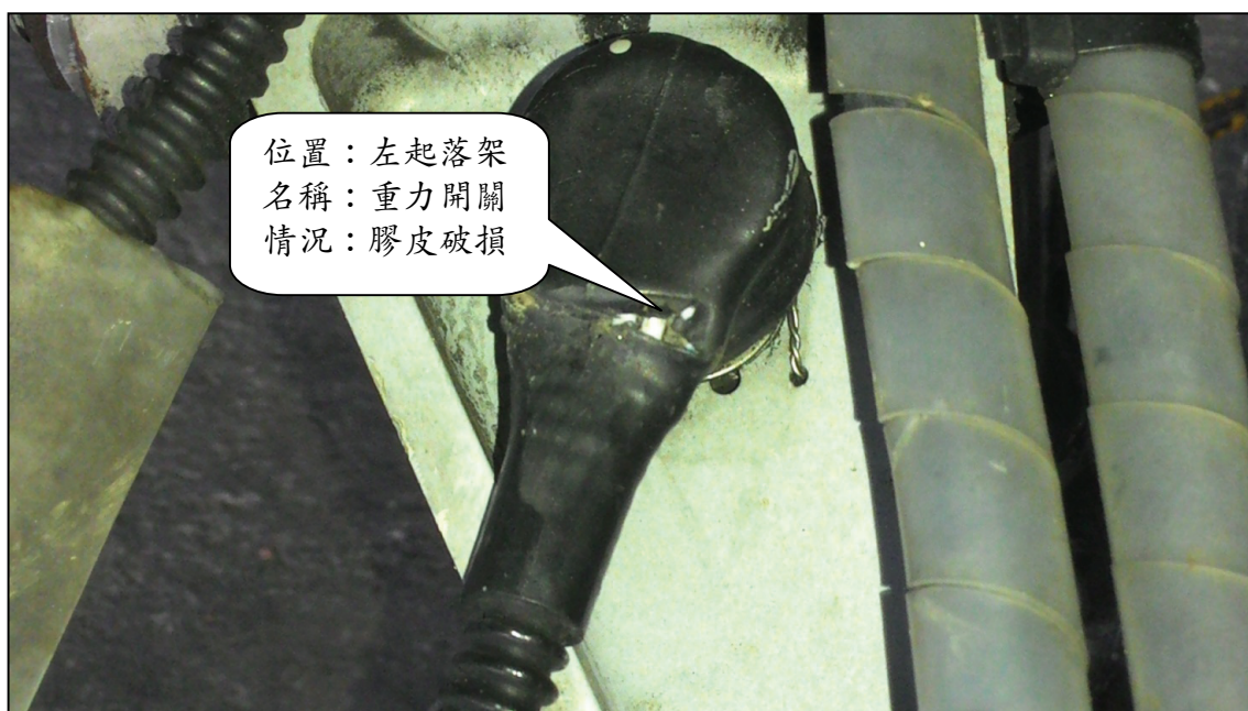
圖 1.6-2 左起落架重力開關膠皮破損
