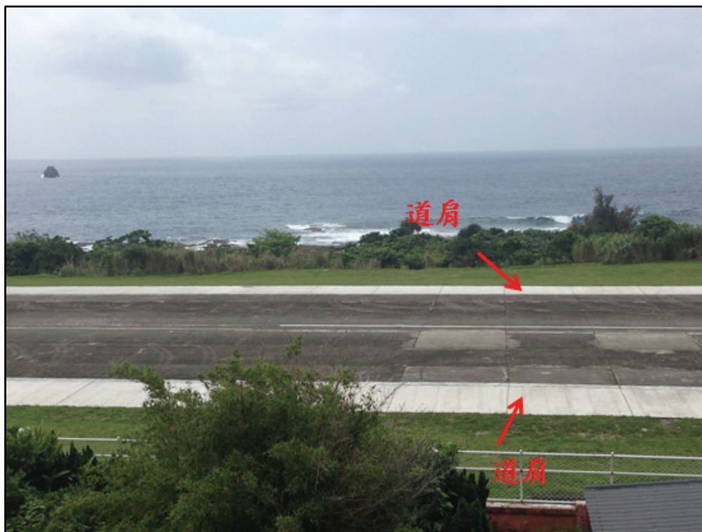
圖 1.10-2 蘭嶼機場跑道水泥混凝土道肩
