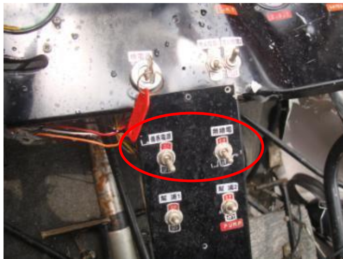
圖 12 儀表及通訊電源置於關閉位置
