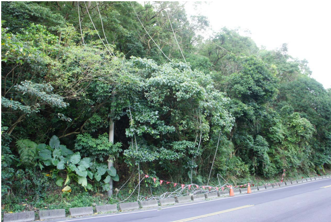
圖 1.4-2 台電電纜線斷落情形 1
