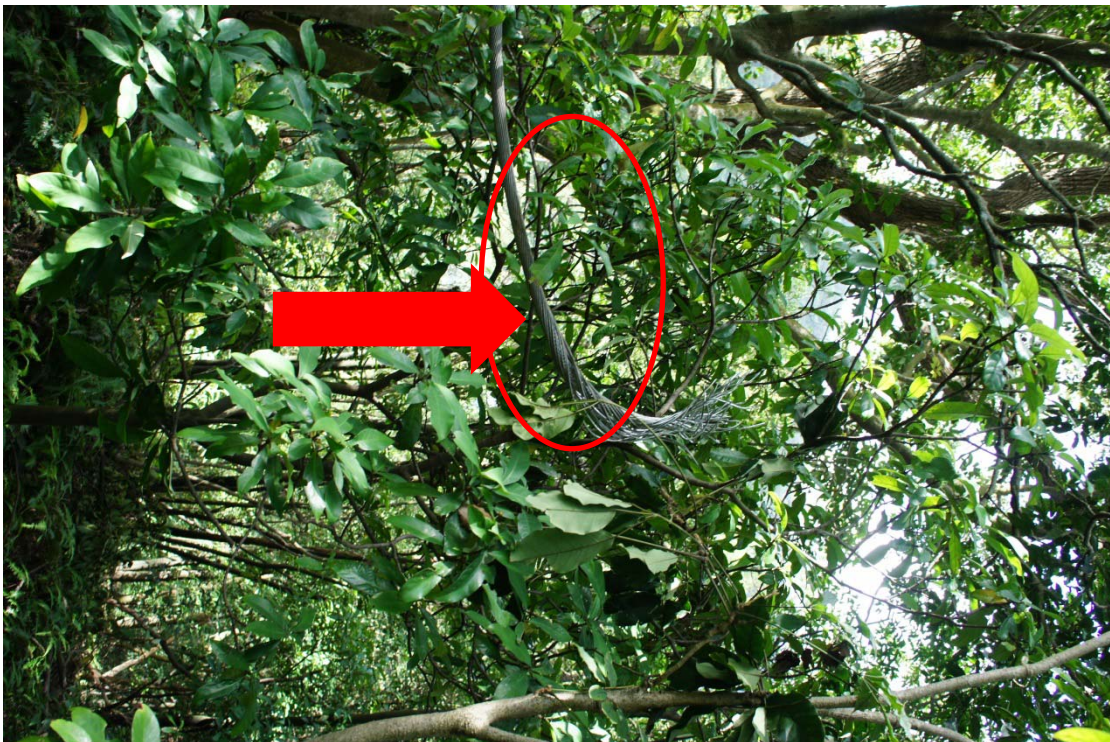
圖 1.4-3 台電電纜線斷落情形 2
