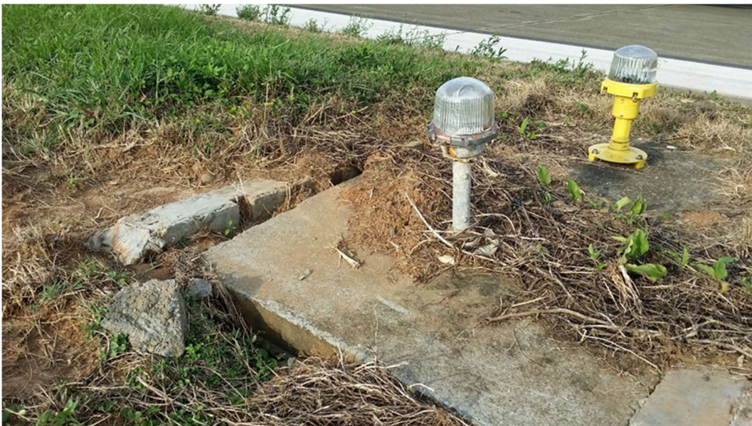
圖 1.10-4 跑道邊燈基座旁不規則形狀之水泥結構
