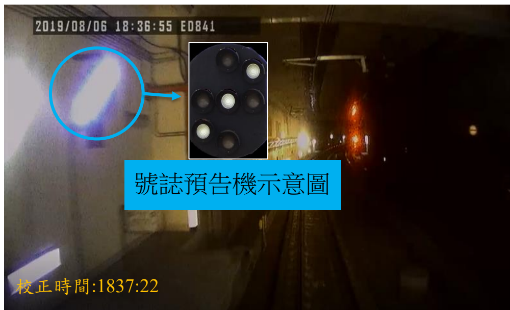
圖 1.12-5 三塊厝站南端之高雄站進站號誌預告機
