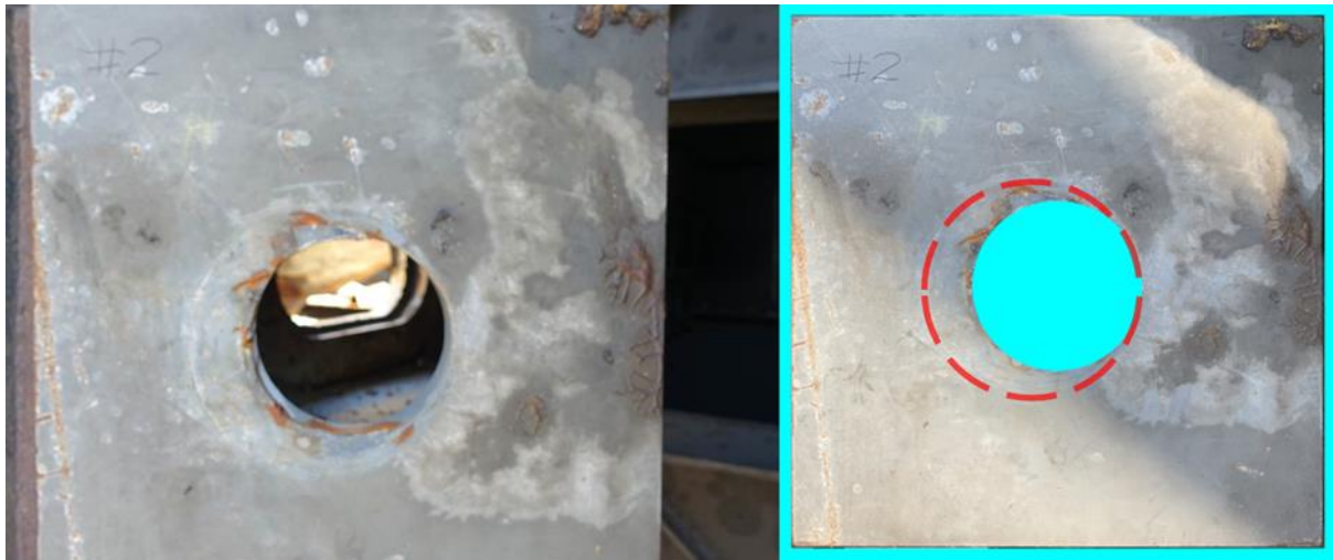
圖 1.10-20 承壓板壓痕偏心現象
