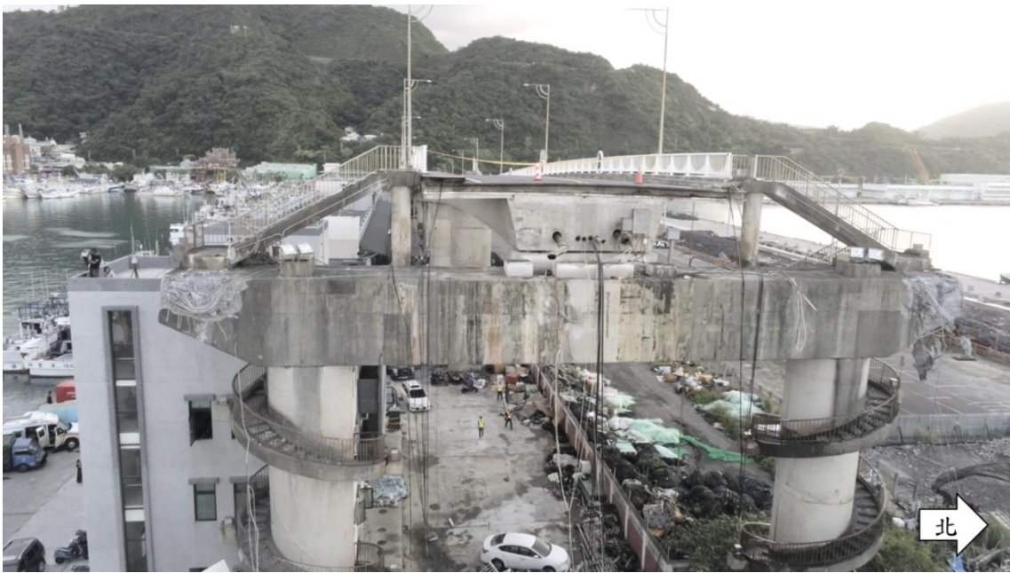
圖 1.9-6 事故後西側橋墩結構損傷情形
