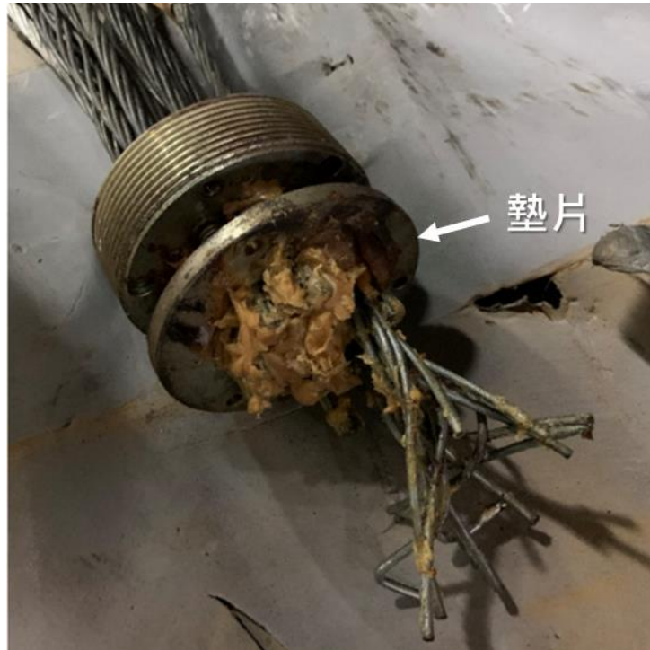
圖 1.10-2 部分錨頭承壓端墊有墊片
