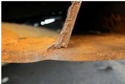
(u) AB10 左側與底板空隙
