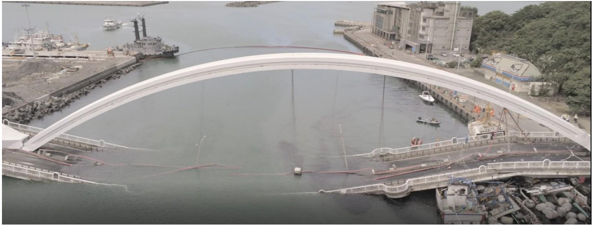
圖 1.3-1 橋梁損害情形
