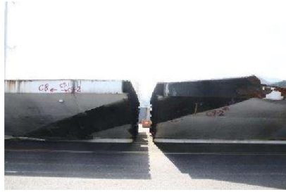
(a) C9-1 節塊與 C9-2 節塊連接斷面
