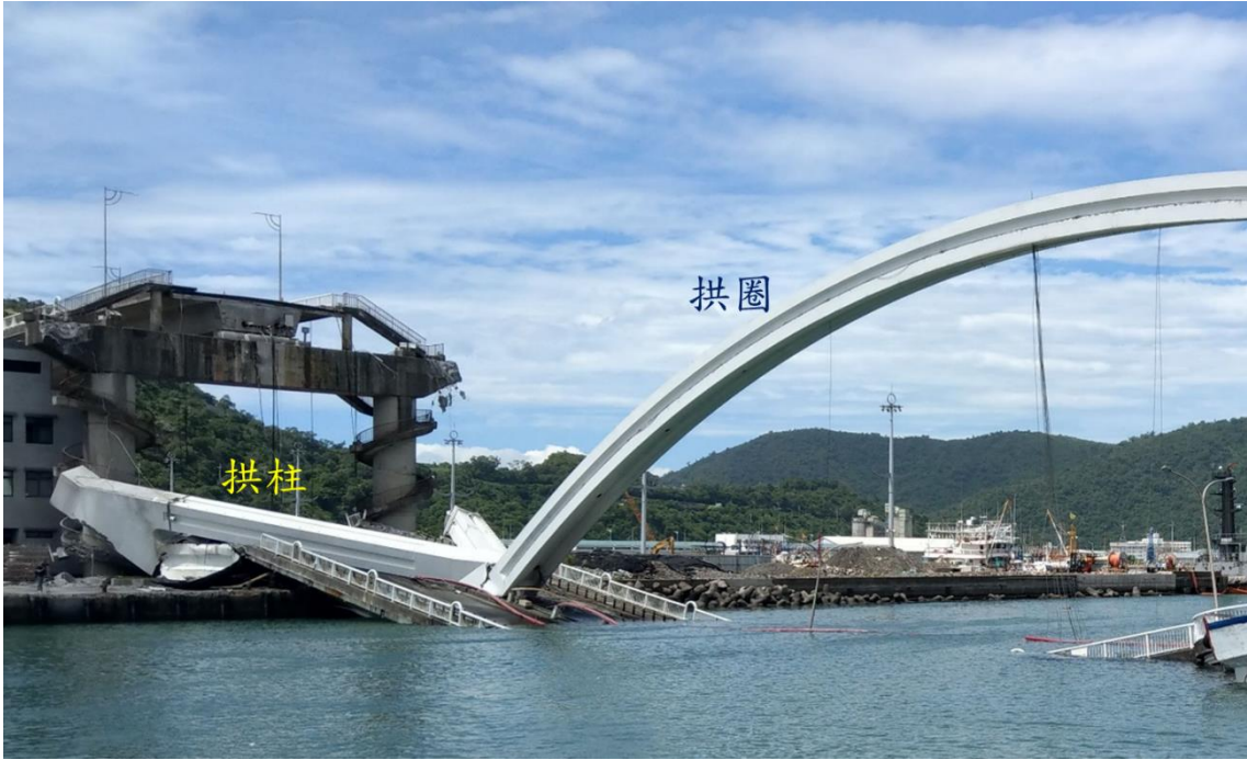
圖 1.5-5 主橋拱架之拱圈及拱柱
