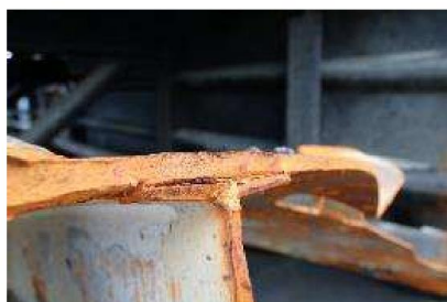
(c) AB3 與 AB4 間垂直向破裂面
