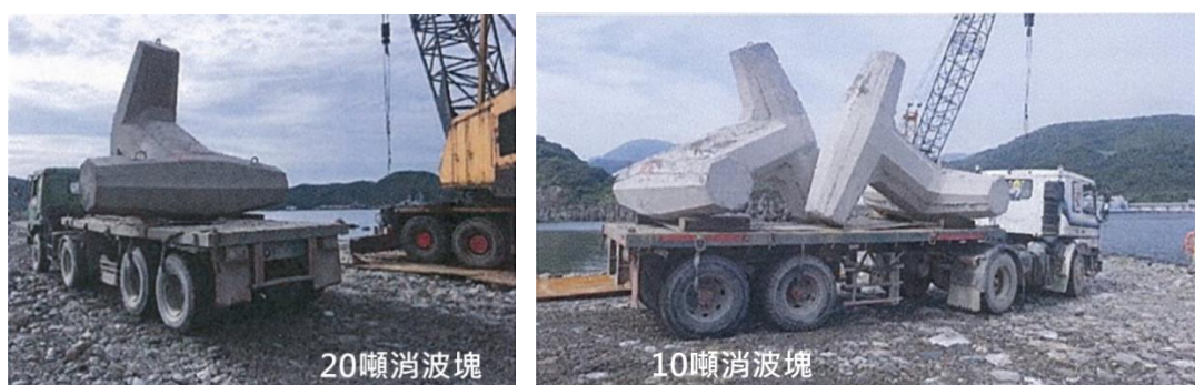
圖 1.6-10 蘇澳港填方區封堵、海堤修復工程載運消波塊車輛
