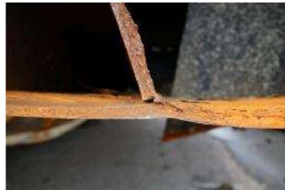
(v) AB10 右側與底板空隙
