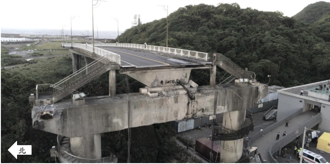
圖 1.9-5 事故後東側橋墩結構損傷情形
