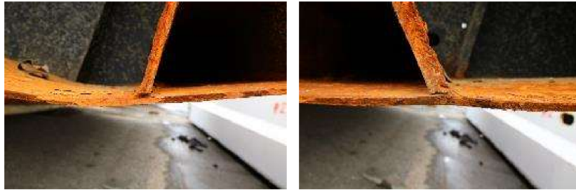
(y) AB11 左側與底板空隙
