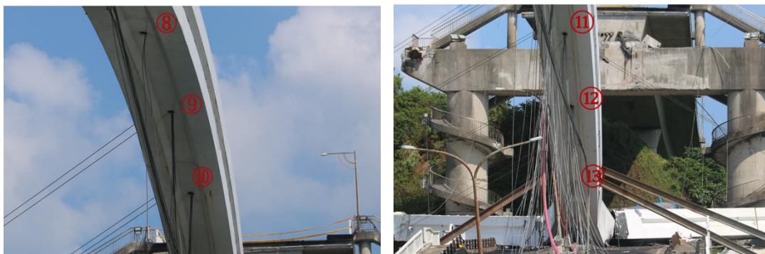
圖 1.10-8 事故後 13 條吊索的殘留狀況
