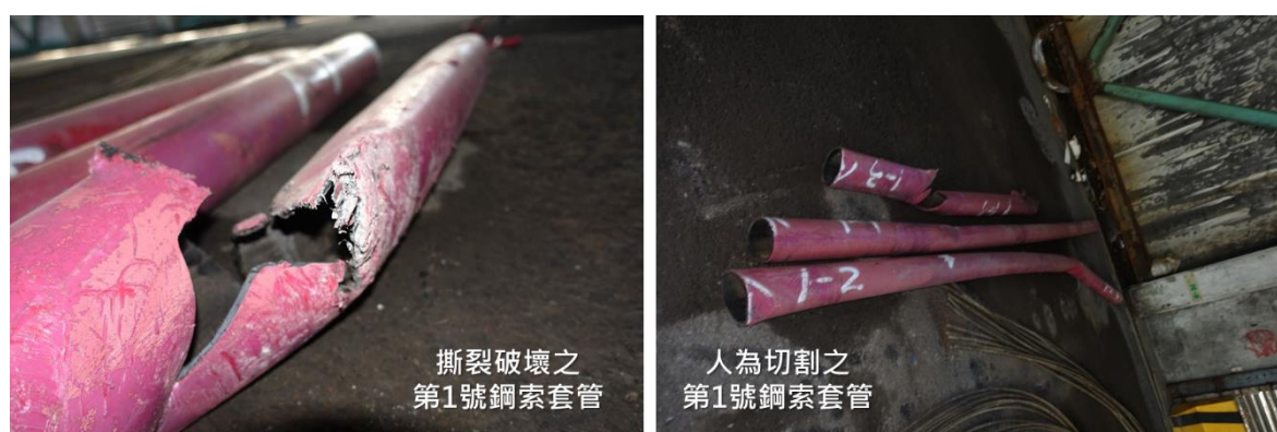
圖 1.10-6 吊索套管破壞狀況
