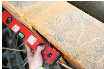
(k)AV1 處腹板斜向破壞
