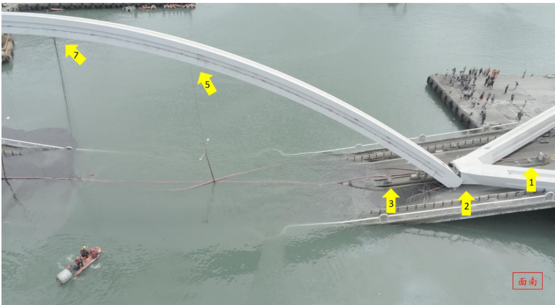
圖 1.10-11 第 1-7 號吊索入水狀況 (面南)
