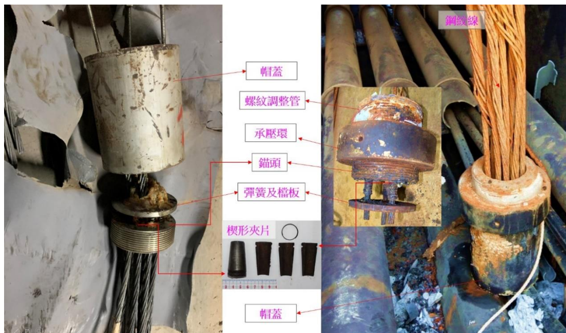
圖 1.10-1 事故橋梁之上下端錨構造圖
