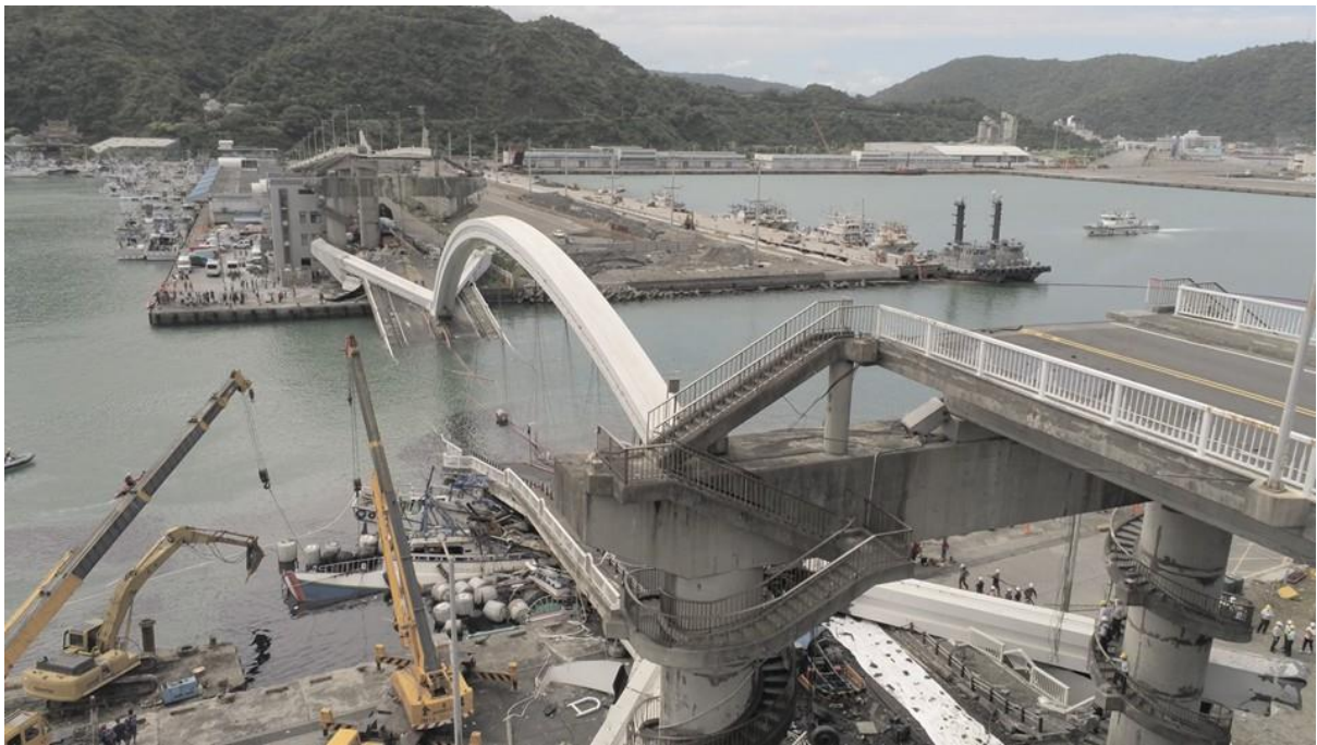
圖 1.1-1 南方澳大橋斷裂情形（一）
