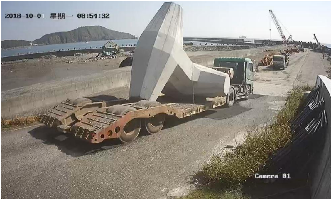
圖 1.6-8 蘇澳港外廓防波堤災損修復工程載運消波塊車輛
