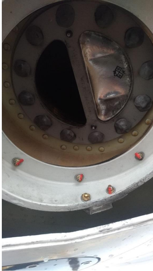
圖 1.6-1 空調地面連接單向閥失效位置
