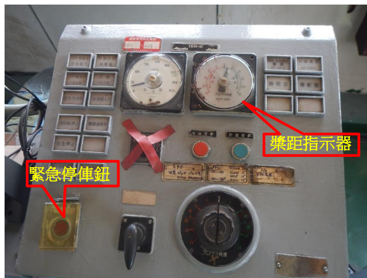
圖 3 緊急停俾按鈕及槳距指示器
