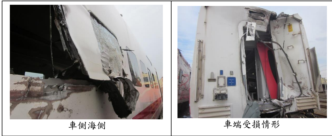
圖 1.3-8 第 6 車車廂損傷概況圖
