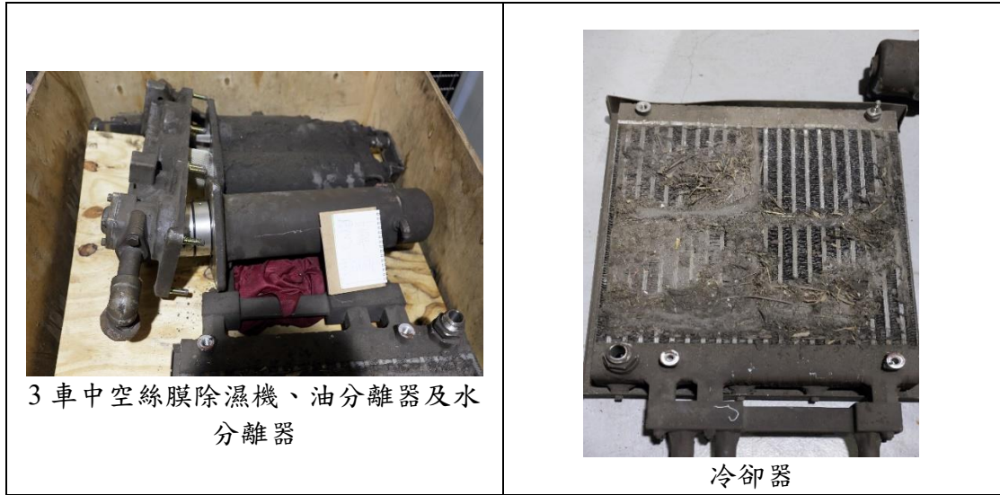
圖 1.3-14 第 3 車損傷概況圖
