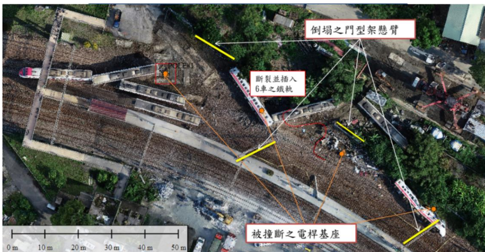
圖 1.12-3 事故次日現場列車及周遭環境受損分布情形
