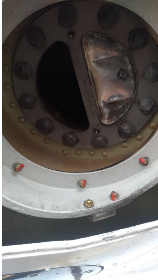
圖 1.6-1 空調地面連接單向閥失效位置
