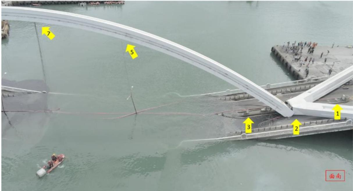
圖 4、第 1-7 號吊索入水狀況 (面南)
