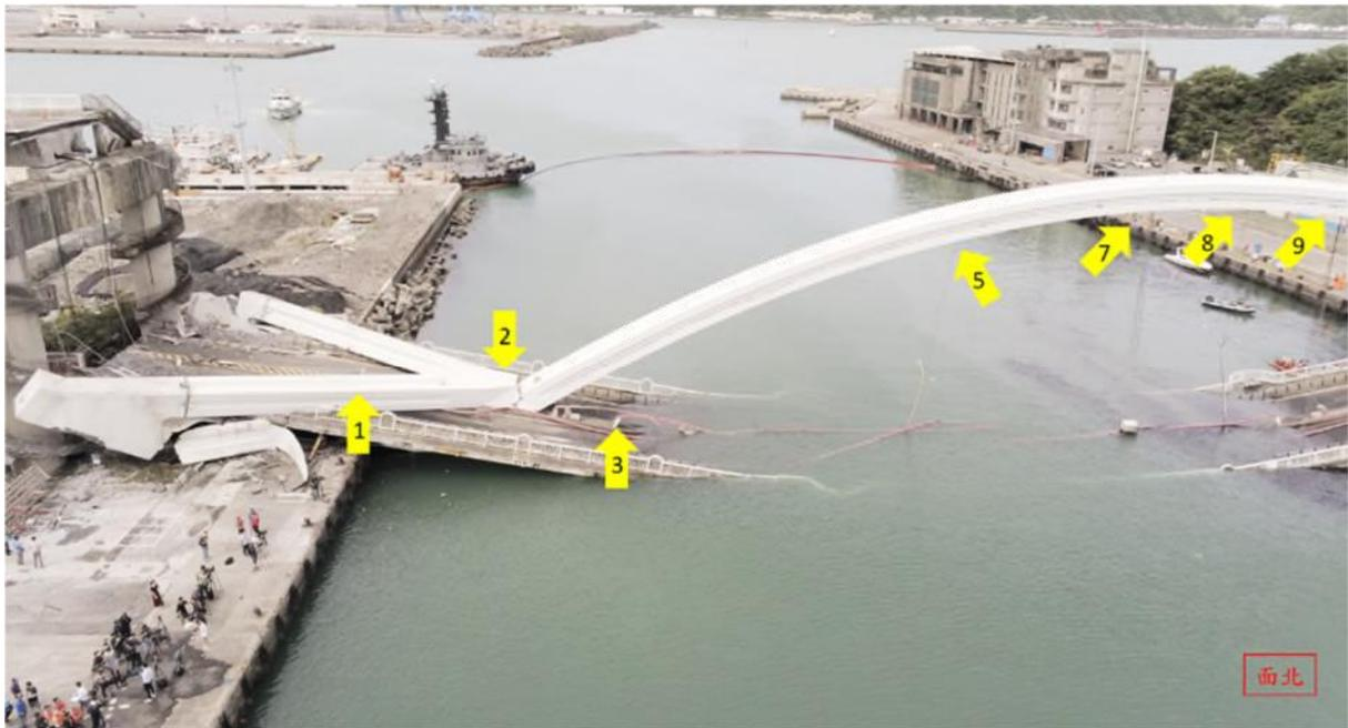
圖 3、第 1-9 號吊索入水狀況（面北）
