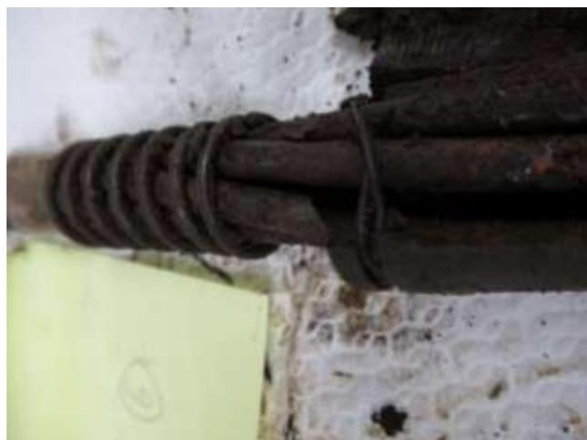
圖160 橋面 13 號錨頭殘留之鋼絞線 13-5 束外觀
