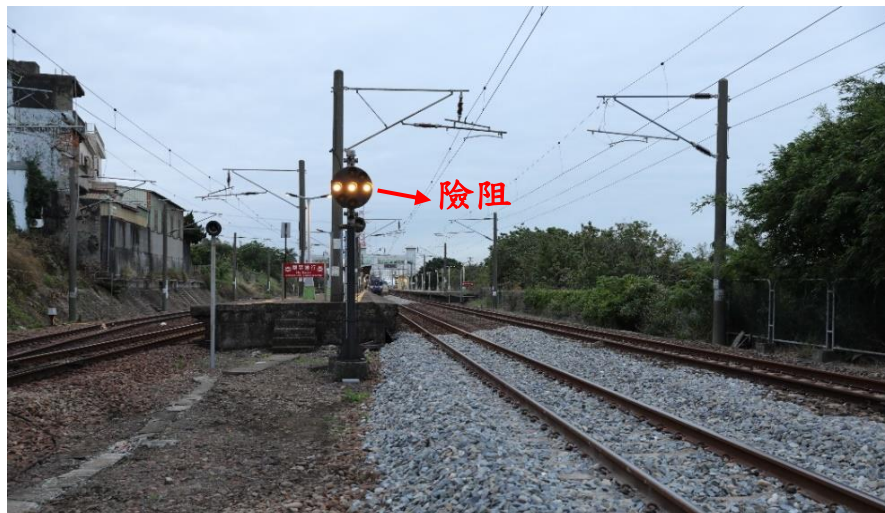
圖 1.1-3 通霄站第三股道北端出發號誌預告機（非事故當時拍攝）
