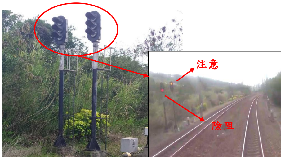
圖 1.1-2 通霄站北端進站號誌機（非事故當時拍攝）
