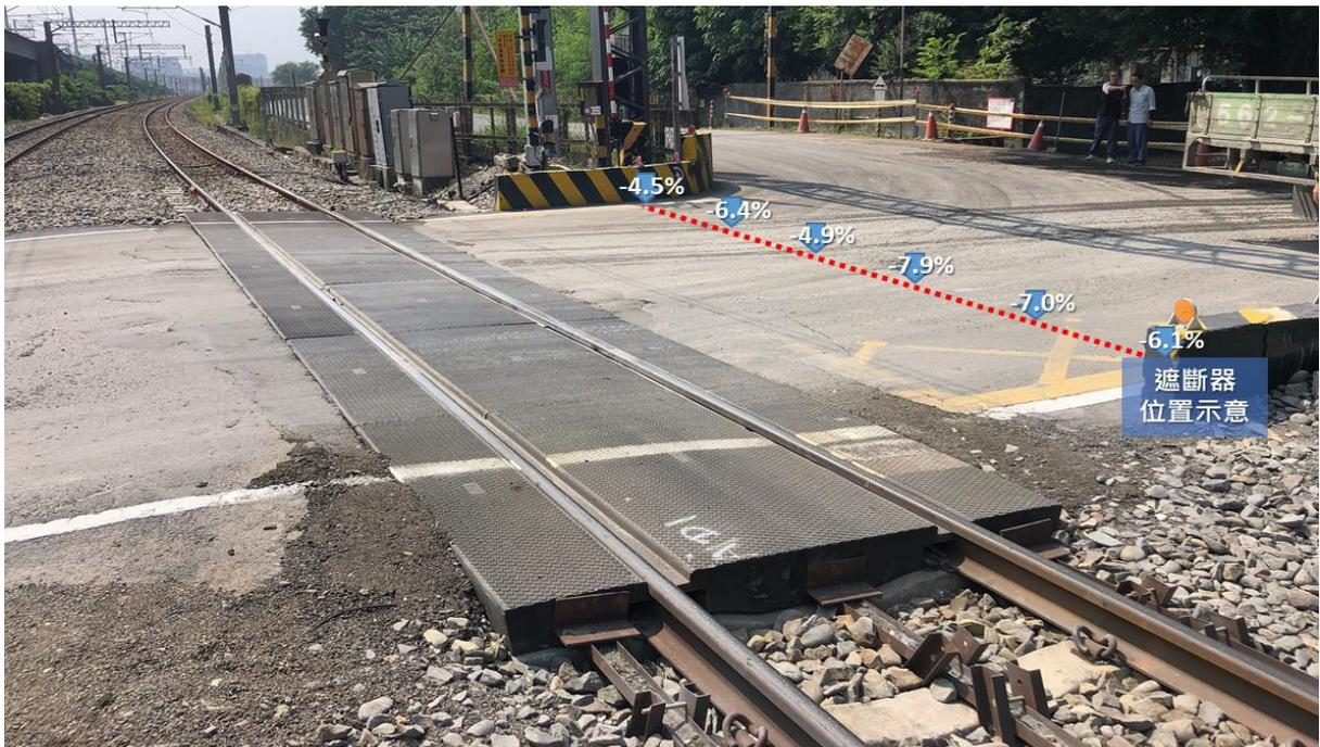
圖 1.5-11(b) 平交道西側坡度示意圖
