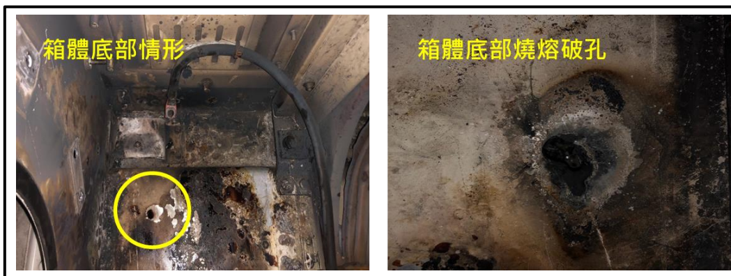
圖 1.14-2 民國 107 年電感電容濾波器燒損相片-2
