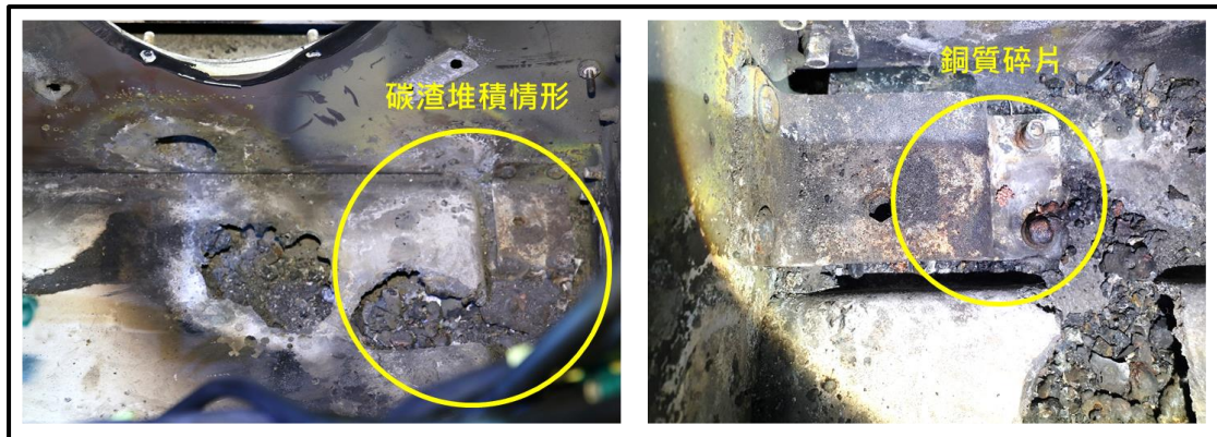
圖 1.10-6 電感電容濾波器銅質線圈受損情形
