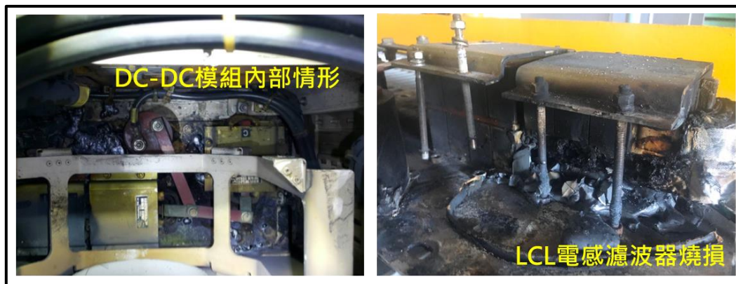
圖 1.14-1 民國 107 年電感電容濾波器燒損相片-1
